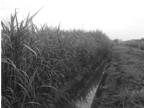
Figura 17. Dren piloto limpio.
