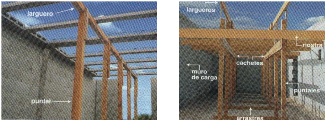
Fig. IV. 19 y IV.20 Colocación cimbra para losa
