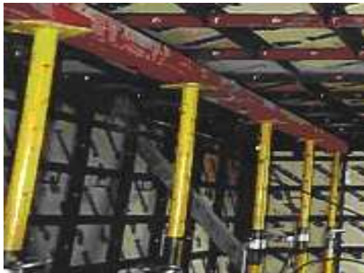
Fig. IV. 12 Apuntalamiento de cimbra con pies derecho
