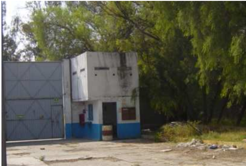
Fig. VI.9 Caseta de vigilancia
