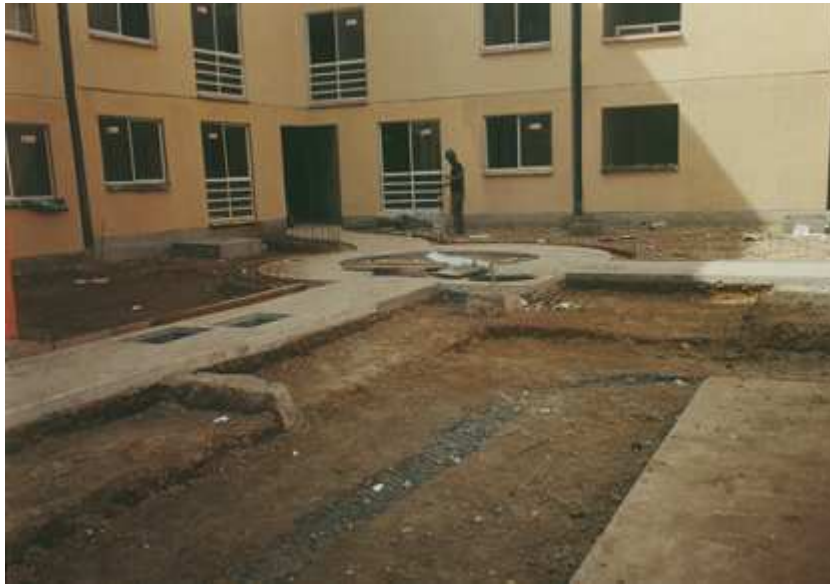
Fig. VI. 14 Inicio de trabajos en accesos a edificios
