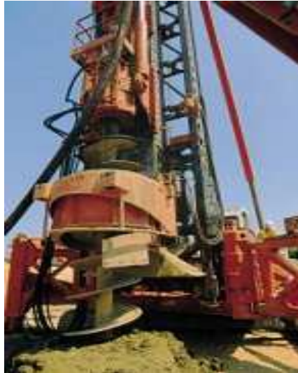
Fig. IV. 3 Perforación por rotación
