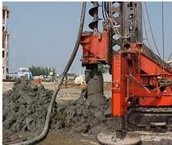
Fig. IV. 4 Retiro de barrena con extracción de material
