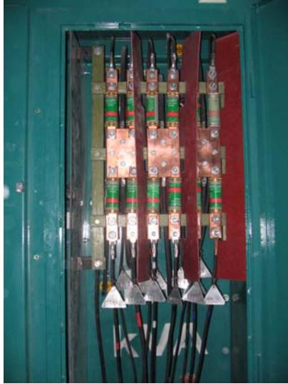
*La fotografía 5. 17 muestra el Bus interior tipo pedestal o tipo H.*
