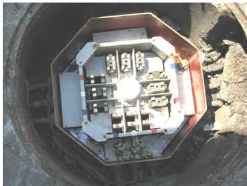
*La fotografía 4.3 Muestra caja de seccionamiento CS 4-500 para red de B.T.*
