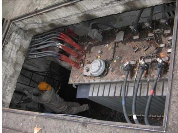
*La fotografía 5.11 Muestra S.E. tipo bóveda con transformador DC*
