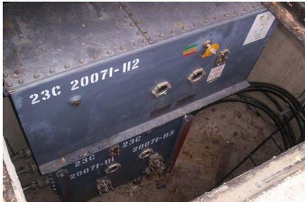
*Fotografía. 5.8 Interruptor CSV 23 kV. 3 vías, 600 A.*
