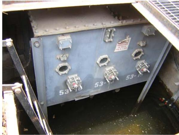
*Fotografía. 5.9 Interruptor CS 23 kV. 3 ó 4 vías, 600 A.*
