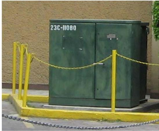
*La fotografía 5.2 Muestra Transformador DRS Pedestal 23-BT*
