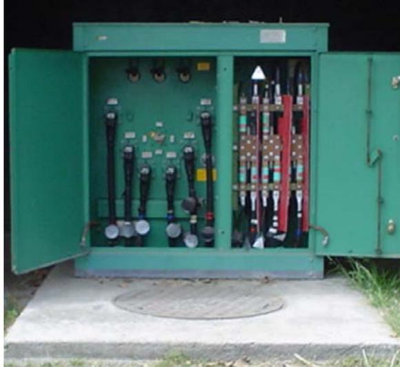
*La fotografía 5.13 Muestra S.E. tipo pedestal con transformador DRS.*
