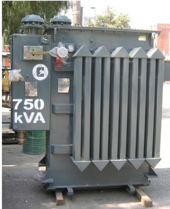
*La fotografía 5.5 Muestra transformador tipo sumergible, 23-BT. Con desconectador.*
