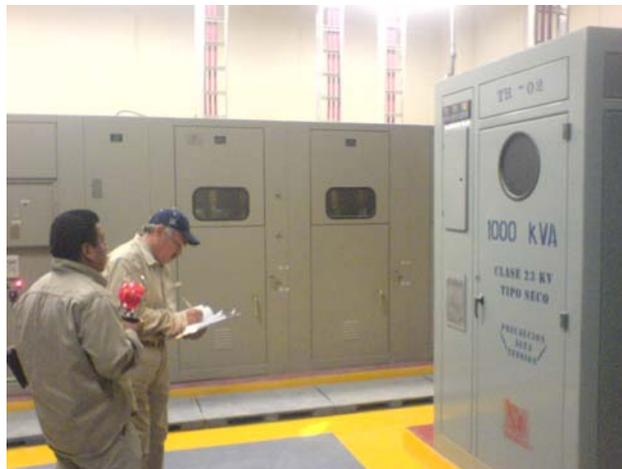
*La fotografía 5.14 Muestra S.E. particular con transformador S.E Interior.*
