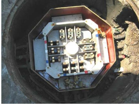
*La fotografía 5.20 Muestra caja CS 4-500 de seccionamiento para red de B.T.*
