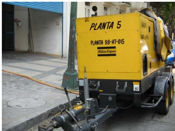
*La fotografía 5.15 Muestra Planta de emergencia móvil de 120 kW.*
