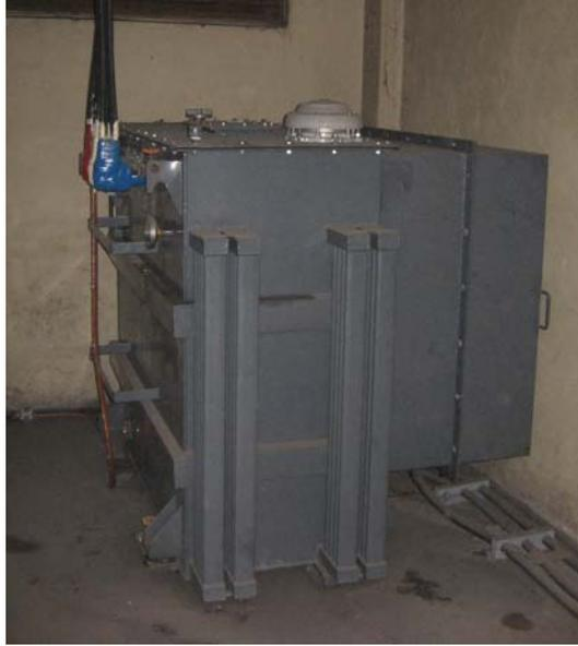
*La fotografía 5.4 Muestra Transformador tipo interior 23-BT. Sin desconectador.*
