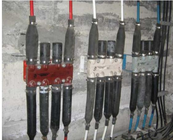
*La fotografía 5.19 Muestra Bus cubierto FS 6.800 y 8.800 Instalado en S.E tipo bóveda.*
