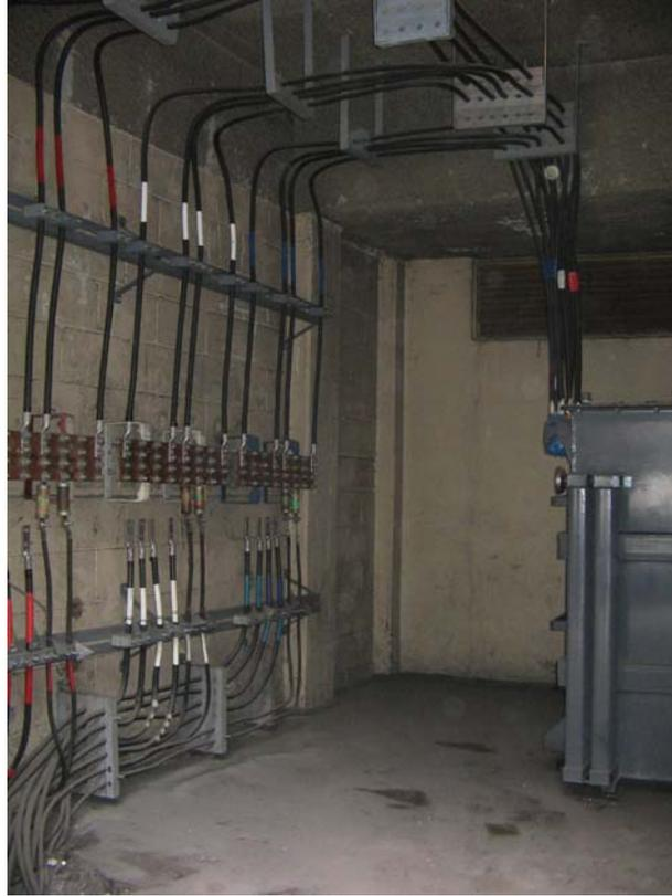
*La fotografía 5.12 Muestra S.E. tipo interior con transformador sin desconectador.*
