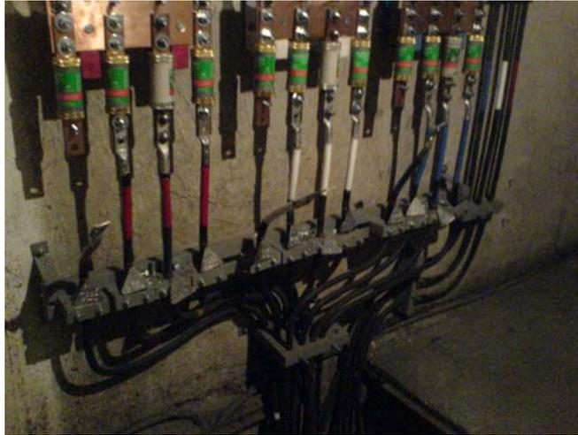
*La fotografía 3.1 Muestra la protección de los circuitos a la salida de la subestación con fusibles de cartucho renovable tipo CR.*
