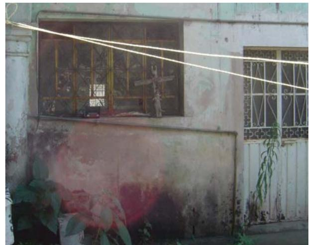
Los daños por oxidación se limitan a las puertas y ventanas no afectan en ningún momento a la estructura, debe entenderse que estas herrajerías no pertenecen a la construcción original.
