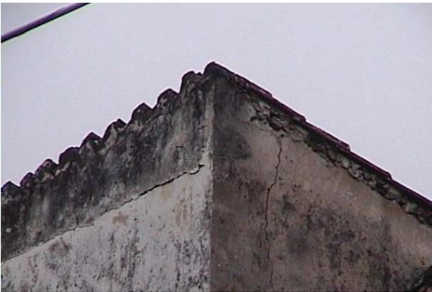
Las fisuras encontradas son en su mayoría causadas por incompatibilidad de materiales en el caso de esta cumbre un cerramiento de concreto que no logro una adecuada unión con el muro de piedra.
