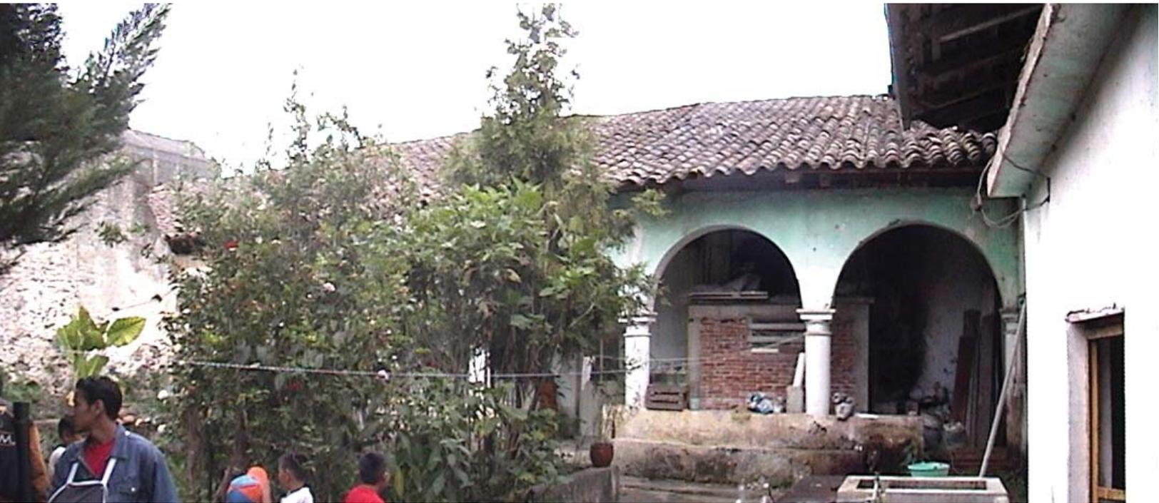
De manera general se puede decir que el estado de la edificación es bueno, no presenta inestabilidad estructural ni grietas o alteraciones que pongan en peligro su constitución física. Tiene una gran cantidad de agregados y alteraciones de espacio original y para estas se han utilizado materiales no comunes a la época en que se construyó sino más contemporáneos como el tabique rojo.
