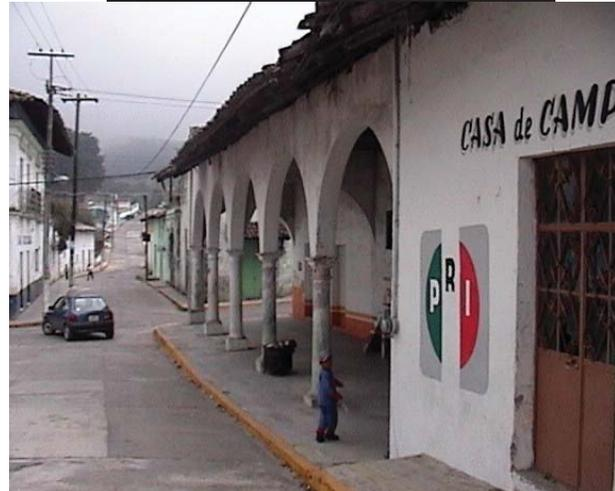
De manera general se puede decir que el estado de la edificación es bueno, no presenta inestabilidad estructural ni grietas o alteraciones que pongan en peligro su constitución física. Tiene una gran cantidad de agregados y alteraciones de espacio original y para estas se han utilizado materiales no comunes a la época en que se construyó sino más contemporáneos como el tabique rojo.
