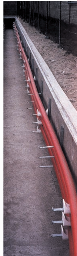
Trinchera en subestación
