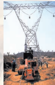
Tendido de conductor en torre de transmisión, hasta 3 conductores por fase y 400 kV
