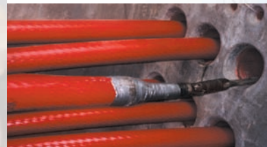
Tendido de cable para 115 kV con ojillo de tracción
