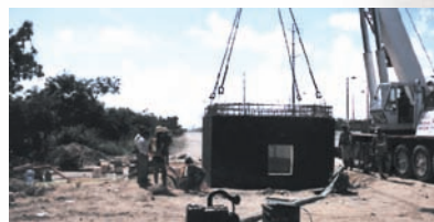
Llegada de registro a sitio de obra
