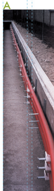
Trinchera en subestación
