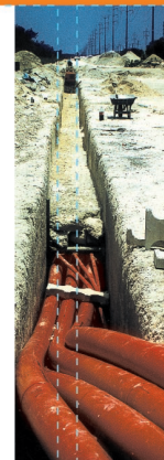
Canalización a cielo abierto
