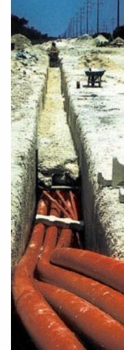
Canalización a cielo abierto
