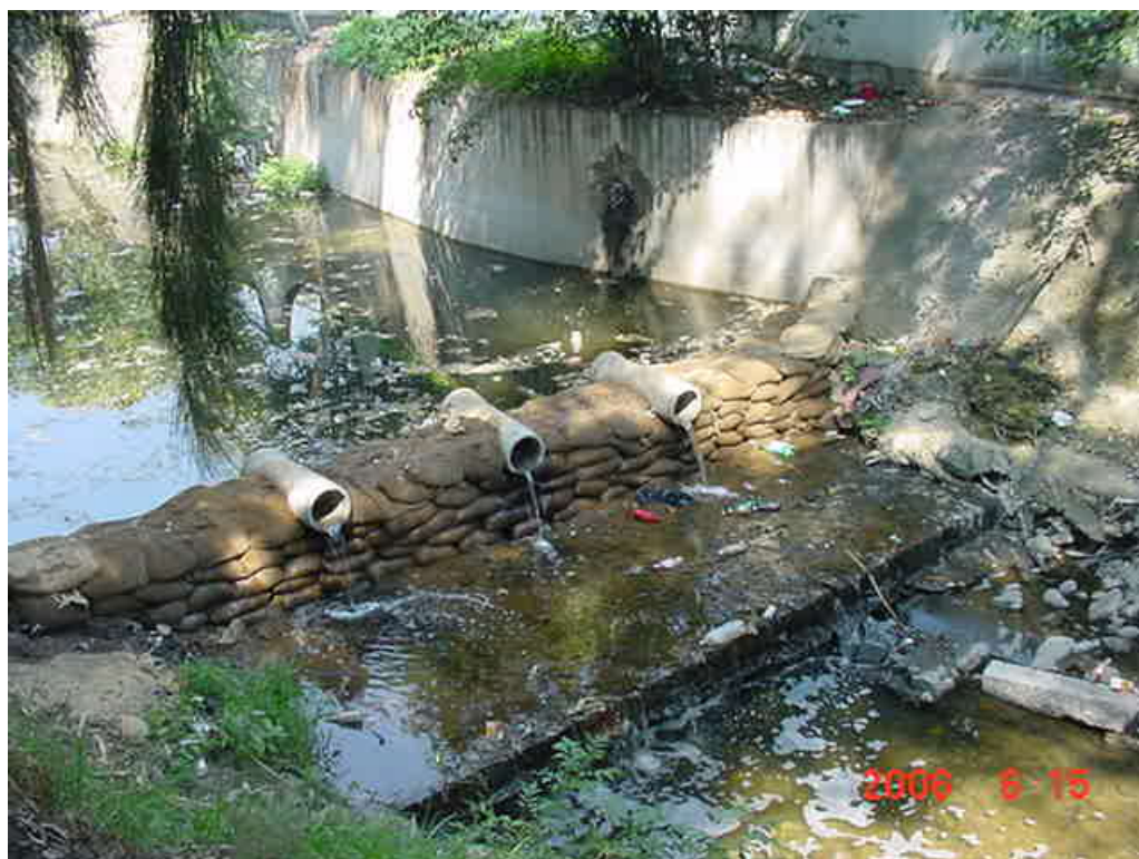
Fotografía 8. Otra vista del “dique” de costales para ayudar a subir el nivel del río Magdalena al final de la investigación
