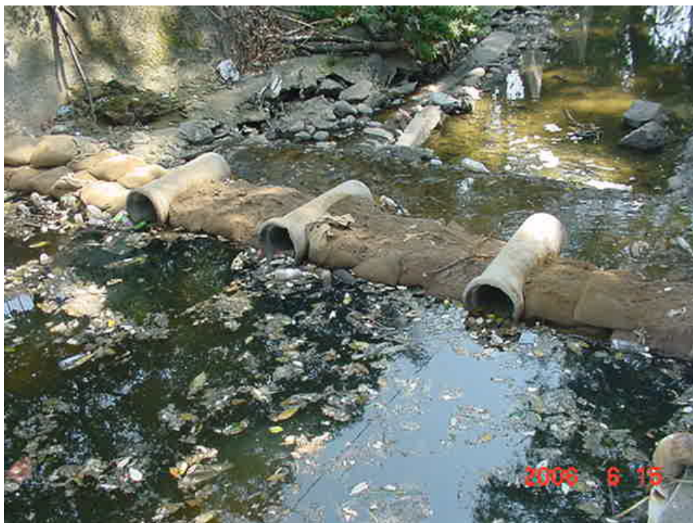
Fotografía 7. Instalación de un “dique” de costales para ayudar a subir el nivel del río Magdalena al final de la investigación
