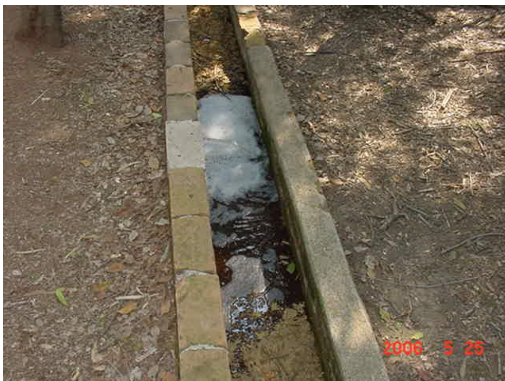
Fotografía 6. Salida del agua tratada de la cisterna a los canales de riego del Vivero Forestal de Coyoacán
