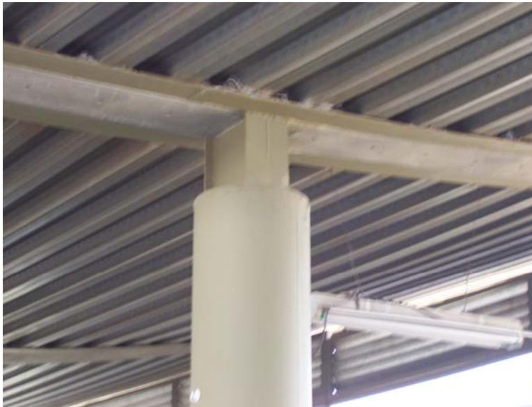
Detalle de columna de acero cubierta de concreto con vigas de acero y el material de la cubierta (losacero).
