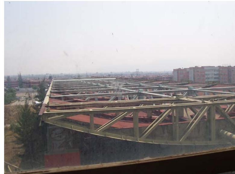
Cubierta del edificio, esta formada por armaduras de acero y resuelta en losacero
