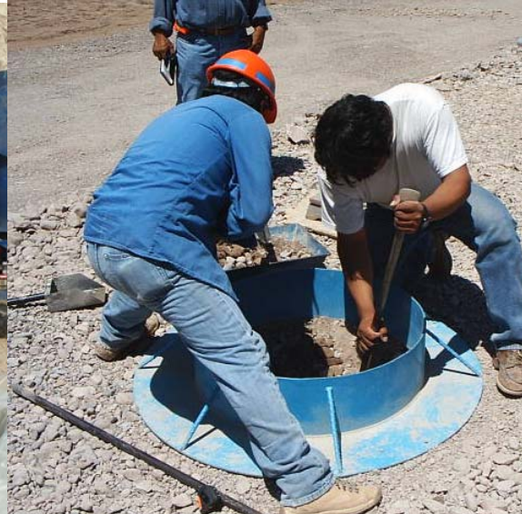
Figura 4. Excavación de la cala
