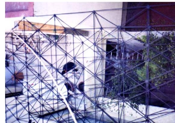
Fotos 62, 63 y 64.- Cubierta ligera para tapar área de jardín, en el que los apoyos aislados son tres en la capa superior y uno en la capa inferior.
