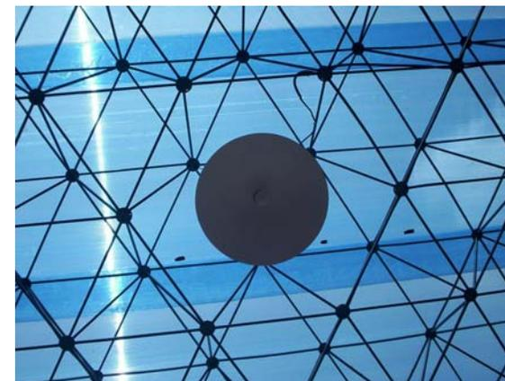
Foto 56.- Supresión de barras de la capa inferior, para alojar luminaria
