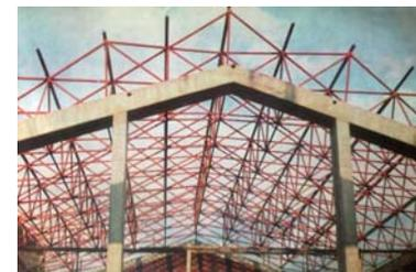
Foto 11.- Sistema Oktaplatte para cubierta de una iglesia en Neuss, Alemania.
