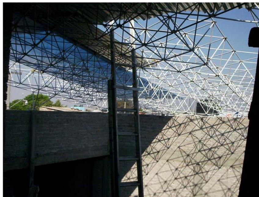
Ya terminado el armado se procederá al izaje, el cual podrá realizarse sin equipo alguno debido a que el peso de la estructura es ligero (Foto 52).
