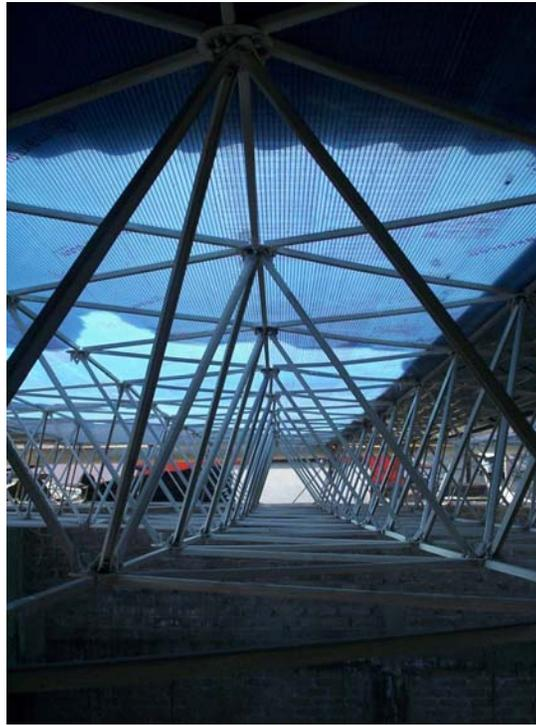
Foto 53.- Cubierta plana tipo de 8 metros de largo posible o de 3 metros en volado, con 41 cm de peralte.
