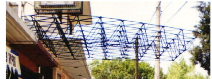
Fotos 70, 71 y 72.- Cubierta tipo en cantiliver de 3.70 m de longitud para enfatizar el acceso al salón de fiestas.
