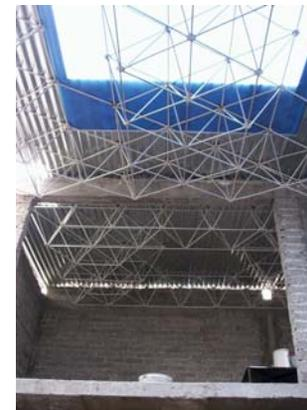
Fotos 73, 74 y 75.- Detalle de huecos en la estructura de la cubierta tipo, con apoyos de la capa inferior directamente sobre muro de tabique.
