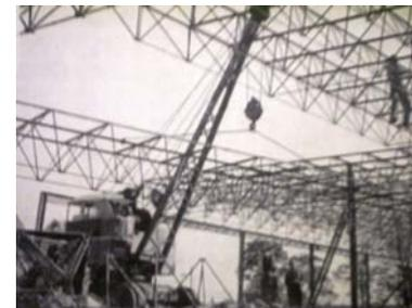
Foto 6.- Cubierta de nave para fábrica con el sistema Space Deck en Inglaterra.
