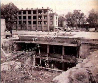
Imagen 2.6.3.1: Obras de construcción de la estación Balderas. ICA.
