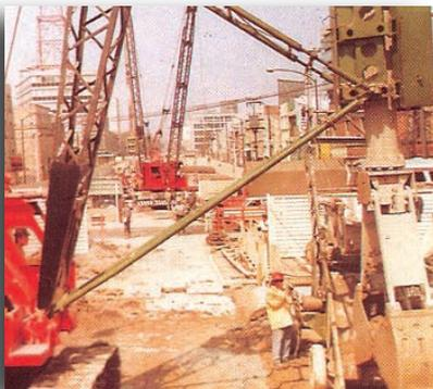
Imagen 2.6.1.3: Excavadoras para zanjas. ICA.
