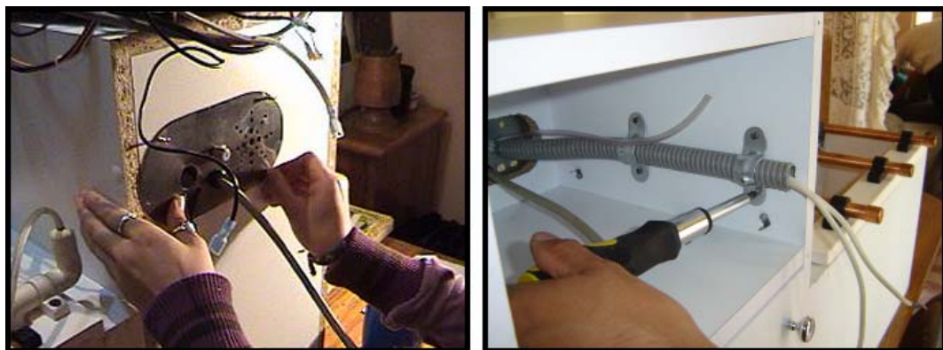
Figura 4.69 a) Posicionamiento de la placa metálica en el mueble; b) Sujeción del cable del calentador.
