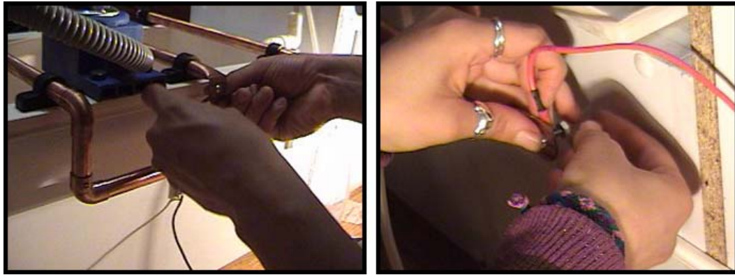
Figura 4.66 a) Conexión de la barra catódica; b) Conexión del punto común de las barras anódicas.
