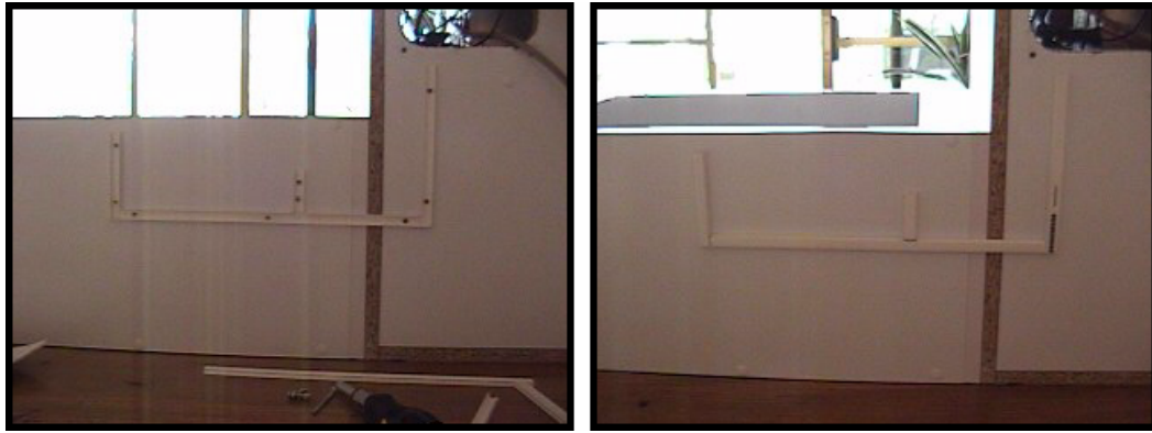
Figura 4.52 a) Base de la canaleta atornillada en la parte posterior del mueble; b) Canaleta completa colocada.
