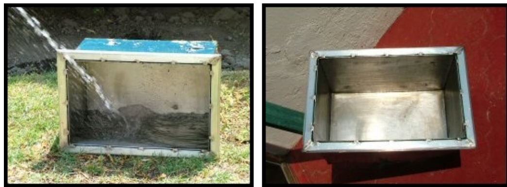
a) Lavado final del interior del tanque; b) interior el tanque listo para la aplicación de la fibra de vidrio.
