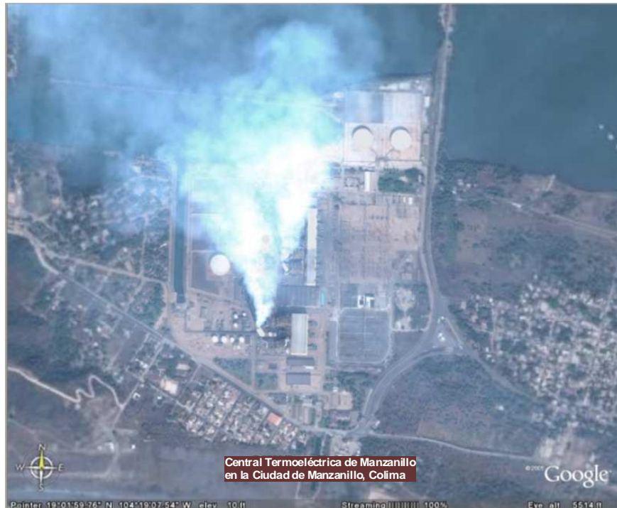
Figura 3. Ubicación de la Central Termoeléctrica “Manzanillo”; en la Cd. Manzanillo, Col.
