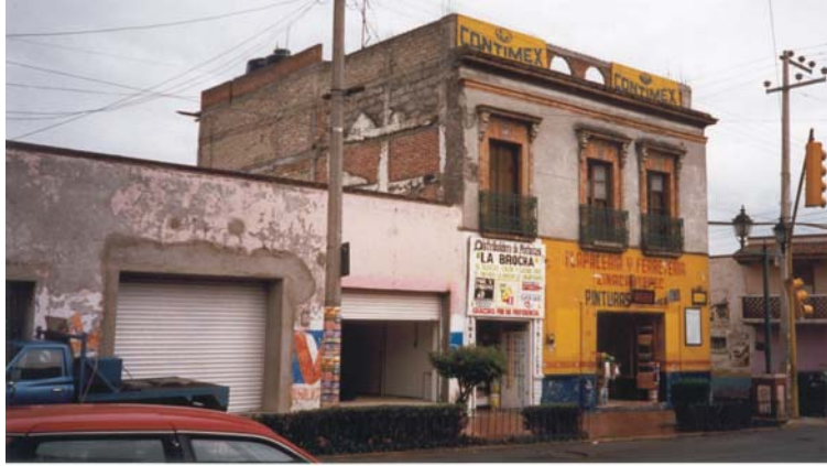
Foto. 1.4.7.f. Estado actual en Av. 16 de septiembre. (SEDUVI, Edo. Mex.,2001)
