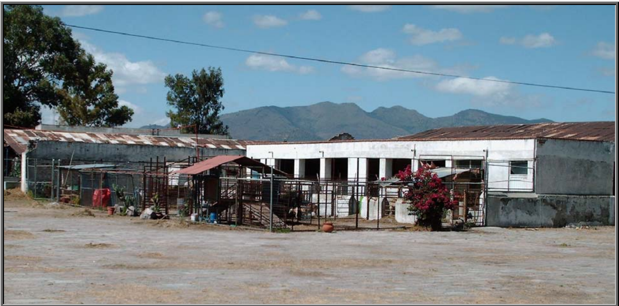
Fotografía 1: Vista lateral exterior de las instalaciones
