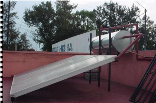
Foto70. Aplicación en México del calentador solar
