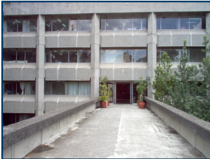
Imagen de las instalaciones del PVE
