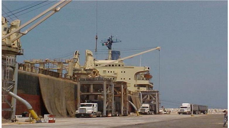
Figura 17 Torres de carga de camiones
