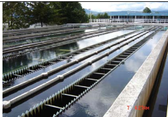
FOTO E.4 SECCIÓN DE SEDIMENTACIÓN
