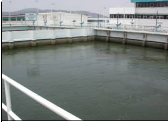
FOTO E.1 TANQUE DE RECEPCIÓN DE AGUAS CRUDAS
