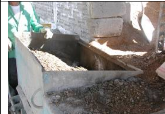
Foto 1.12 Revisión de humedad en la mezcla
