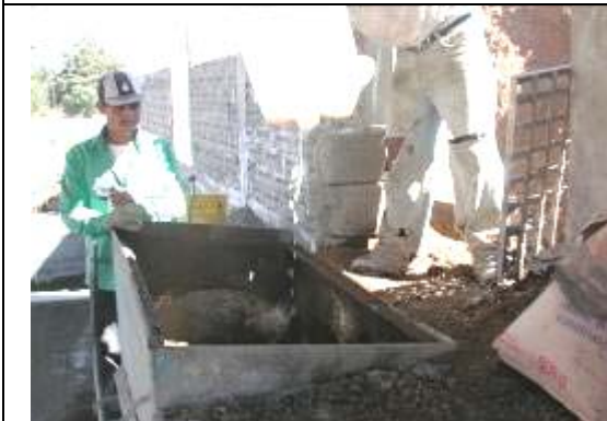
Foto 1.11 Adición de agua en la mezcla
