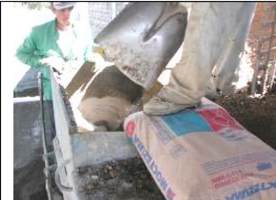
Foto 1.10 Adición de cemento
