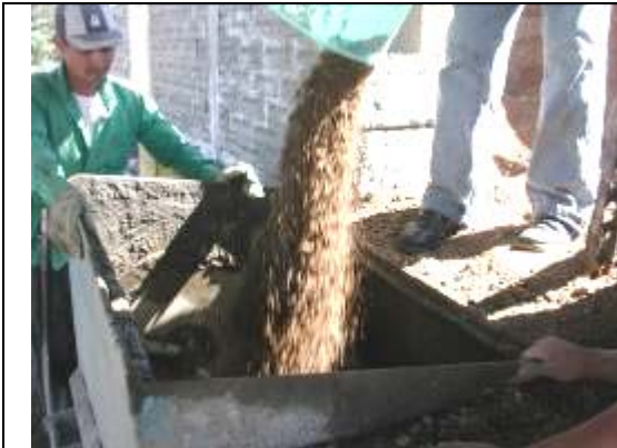
Foto 1.9 Agregado de tepojal y lodo en la mezcladora
