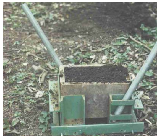
Foto 1.2 Relleno del molde para fabricar adobe
