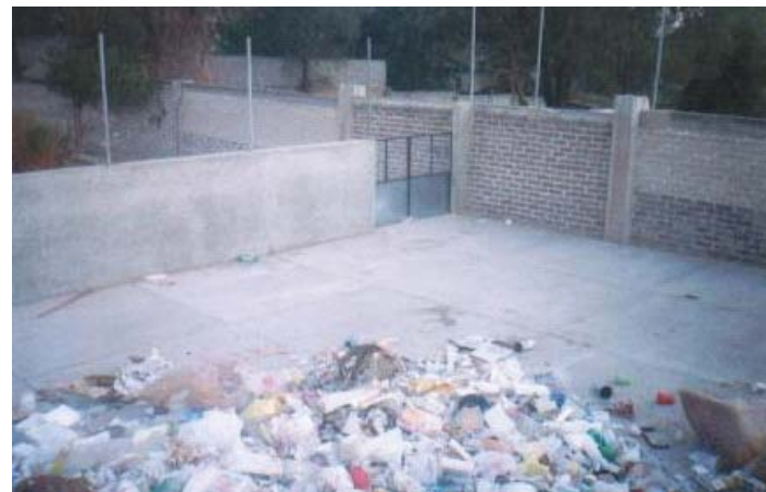
Realidad física actual: como área de acopio de basura y otros desperdicios
