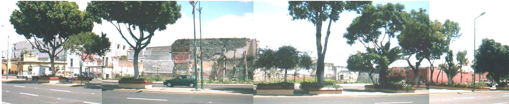
Fig. 14. Vista frontal del predio desocupado. Boulevard Héroes del 5 de mayo.
