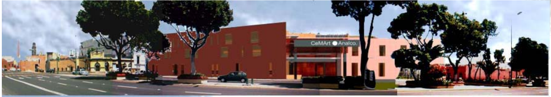
Fig. 24. Fachada principal poniente hacia Avenida Héroes del 5 de Mayo.
