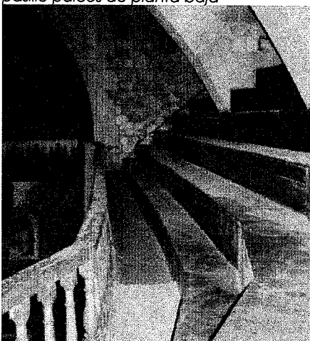
Imagen 17. Vista lateral derecha gradas galería
