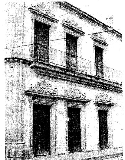
Imagen 2. Vista de Fachada lado derecho, calle Aquiles Serdán
