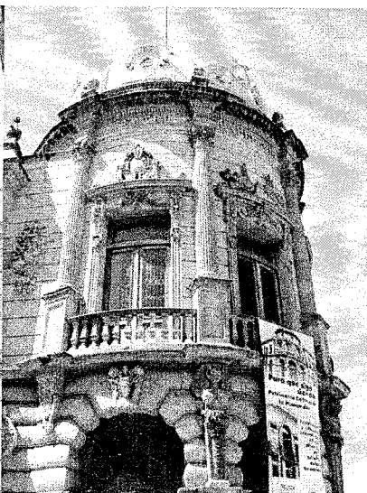
Imagen 21. Observar trabajo de Cantera en la torre esquina del Macedonio Alcalá.
