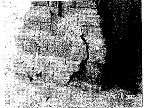
Imagen 27. Basa de columna de cantera con resanes de cemento, con humedad y pulverulente
