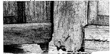
Imagen 27. Basa de columna de cantera con resanes de cemento, con humedad y pulverulente
