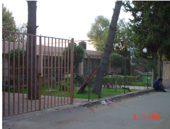
IMAGEN 65 FACHADA PRINCIPAL DEL CENTRO DE SALUD
