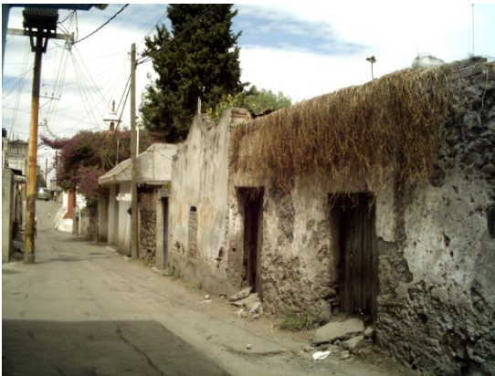
MAGEN 67 CASA HABITACION QUE TODAVIA CONSERVA SUS MUROS DE PIEDRA PEGADOS CON LODO
