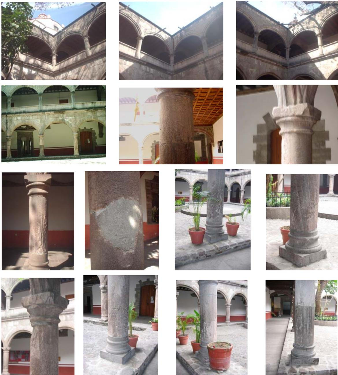
Es posible apreciar que la zona de las arquerías del claustro bajo y alto es la que presenta los daños más severos; y van desde la pérdida de materia e injertos de material distinto a su composición en los fustes de las columnas, fisuras y agrietamientos en algunas basas, y pérdida de materia en capiteles.
