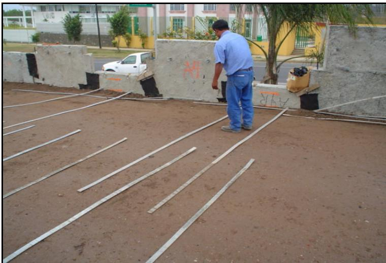
(Imagen 53) Tendido y colocación de armaduras
