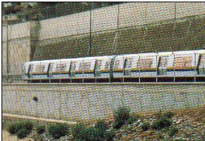
(Imagen 15) Muros de tierra armada para obras ferroviarias.
