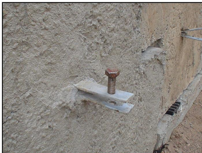
(Imagen 35) Arranque colado y tornillo para arranque.
