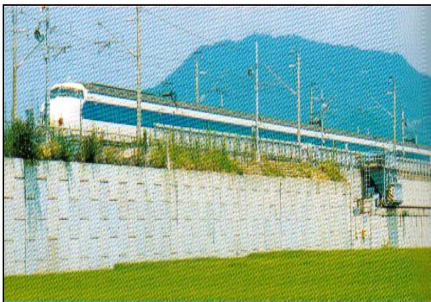
(Imagen 12) Muros de tierra armada para obras ferroviarias.
