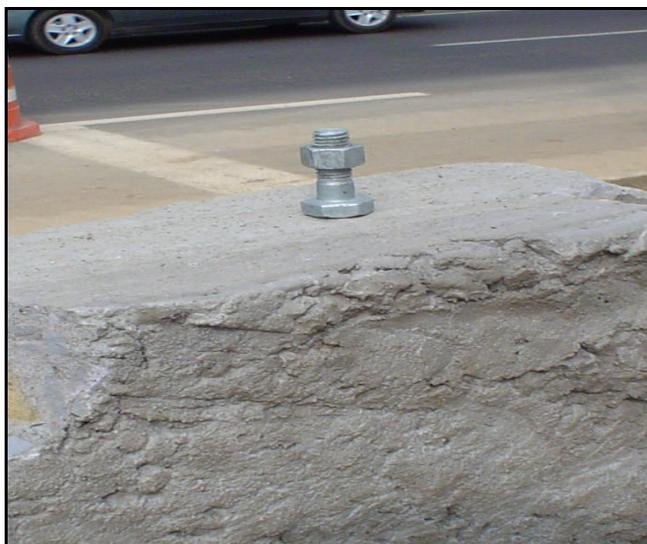
(Imagen 51) Elementos de acero galvanizados, tornillos.
