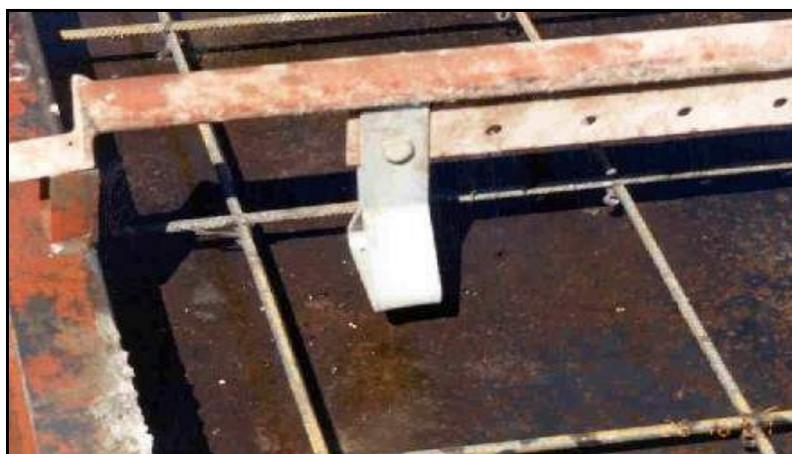
(Imagen 34) Arranque colocado en el molde.
