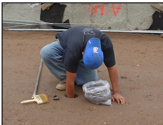
(Imagen 67) Prueba de grado de compactación del laboratorio.
