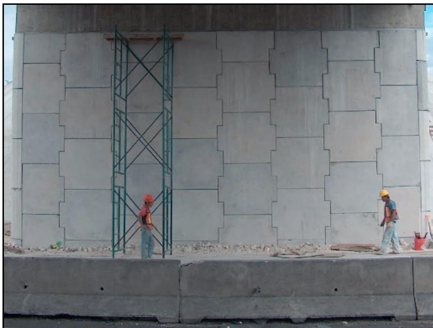
(Imagen 70) Muro de Tierra Armada ya concluido, en este caso utilizado como estribo.
