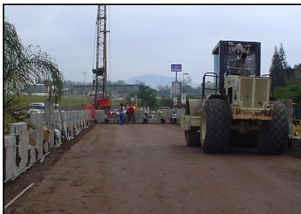
(Imagen 63) Compactación mediante vibro compactador.
