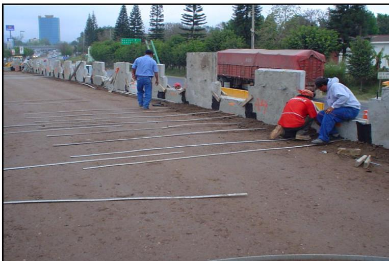
(Imagen 54) Tendido y colocación de armaduras
