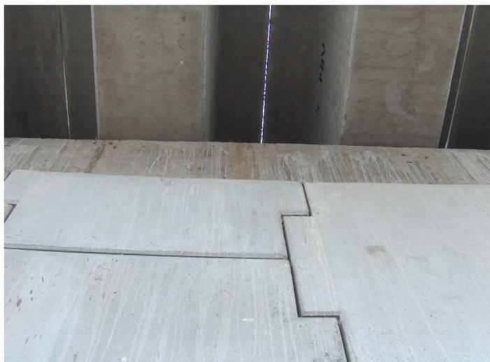
(Imagen 47) Remate de un muro de Tierra Armada.
