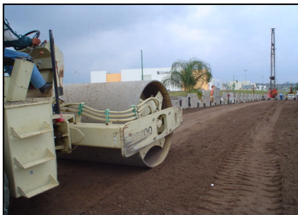
(Imagen 62) Compactación mediante vibro compactador.
