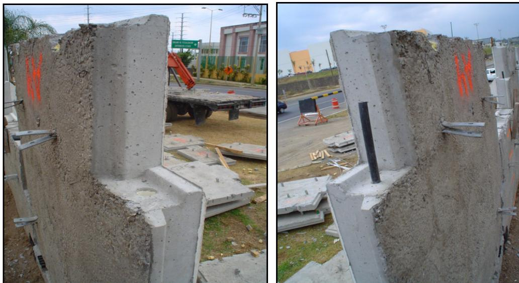
(Imagen 33) Sistema de macho-hembra, izquierda tubo PVC, derecha barra de neopreno.
