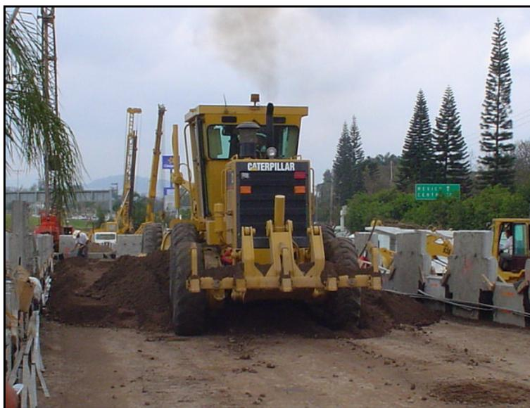
(Imagen 59) Mano de chango y motoconformadora esparciendo el material de relleno.
