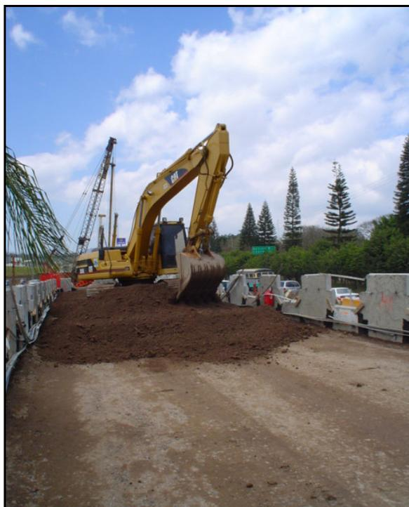
(Imagen 58) Mano de chango y motoconformadora esparciendo el material de relleno
