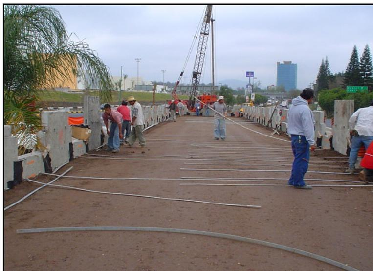
(Imagen 55) Tendido y colocación de armaduras.
