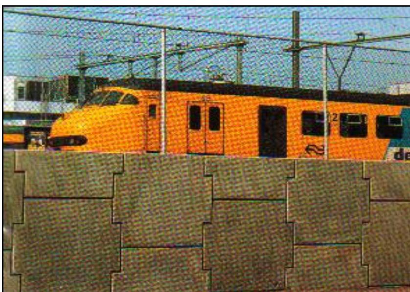
(Imagen 13) Muros de tierra armada para obras ferroviarias.
