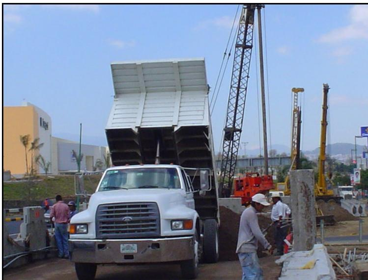
(Imagen 56) Camión listo para vaciar el material de relleno.
