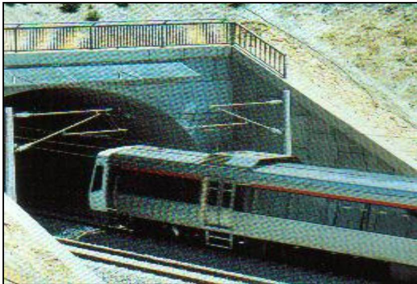
(Imagen 14) Muros de tierra armada para obras ferroviarias.
