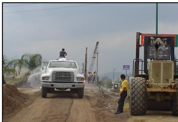
(Imagen 60) Aplicación de la humedad optima para los trabajos de compactación.
