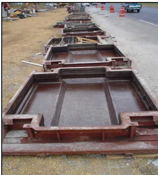
(Imagen 28) Molde para fabricación de escamas.
