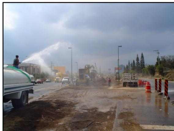
(Imagen 61) Aplicación de la humedad optima para los trabajos de compactación.
