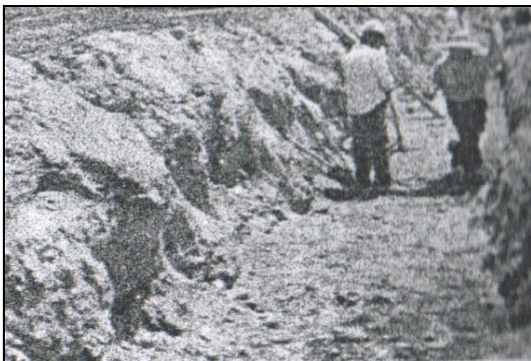
(Imagen 26) Trabajos de excavación para la cadena.
