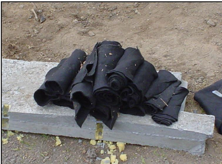
(Imagen 43) Malla geotextil.
