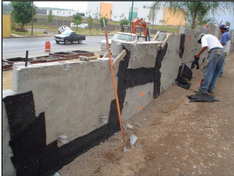
(Imagen 44) Malla geotextil colocada.
