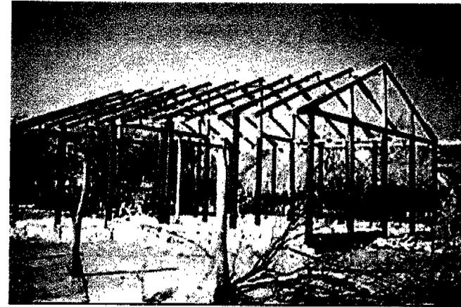
Un ejemplo de bajareque donde se aprecia la estructura principal, tanto de los muros como de la cubierta, lista para recibir el artesanado de madera.
