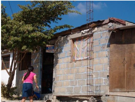
*Construcciones con muros de block con ausencia de asesoría técnica y recursos económicos que se reflejan en la falta de castillos y cadenas adecuadas.*
