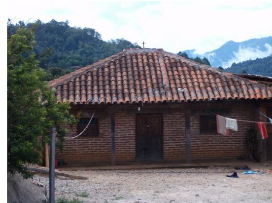
*Casa de ladrillo con corredor al frente, columnas a base de horcones de madera, cubierta a cuatro aguas y teja de barro en la localidad de Nachig, municipio de Zinacantán, Chiapas.*
