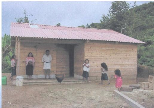
*Vivienda de madera (INVI) con pórtico y cubierta con lámina de fibrocemento en diversas localidades del municipio de Chenalhó, Chiapas.*
