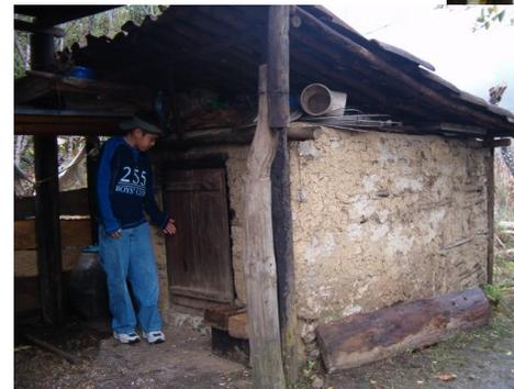
*Temascal tradicional característico de la zona de los altos de Chiapas, esta muestra se localiza en el municipio de Oxchuc, Chiapas; y está construido a base de bajareque y cubierta de lámina galvanizada.*
