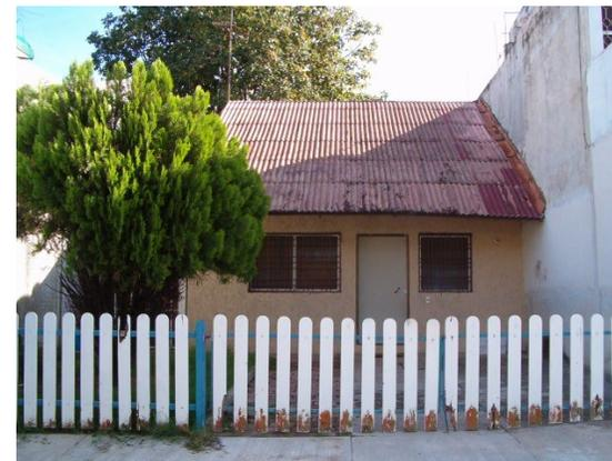
*Algunas muestras del proyecto original de la vivienda progresiva que aún se conservan en la actualidad en la Col. “San José Yeguste”, en donde la estructura de la cubierta es a base de madera, muros de block y cubierta de lámina de fibrocemento.*
