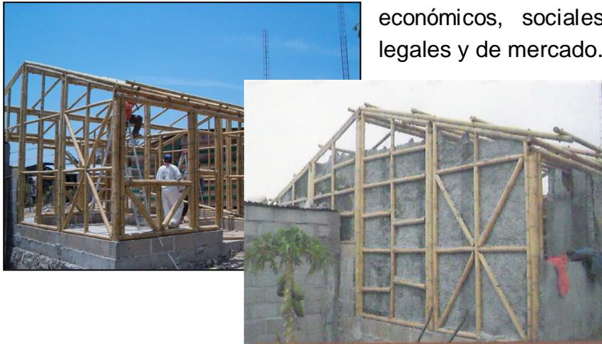
*Proceso constructivo de una casa con estructura de bambú en el fracc. “Yuquis” en Tuxtla Gutiérrez, Chiapas.*
