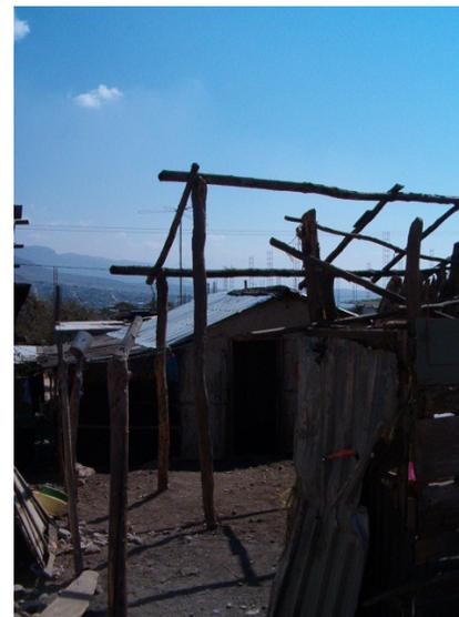
*Una estructura a base de madera, con las mismas características de todas las construcciones, que no reflejan seguridad.*
