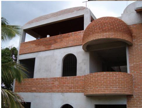
*Nótese el uso del ladrillo en muros, bóvedas sin cimbra y cúpulas en una construcción “moderna”.*
