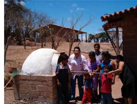
*Horno construido a base de adobe y encalado el exterior para una vivienda de la localidad de “Nueva Esperanza”, municipio de Jiquipilas, Chiapas.*
