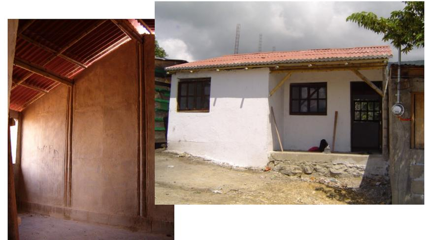
*Vivienda con estructura de Bambú (INVI) aplanado exterior con mortero cem-arena e interiores con tierra-cemento, cubierta con lámina de fibrocemento en dos capas y alma de poliestireno, fracc. “Yuquis”.*
