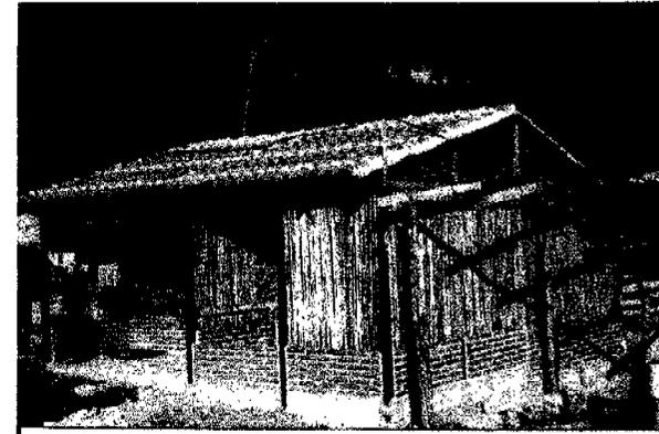
En esta imagen se observa la pendiente negativa hacia el interior del terreno y de la vivienda, aspecto que ayudó para plantear la ampliación de la vivienda dándole continuidad a la pendiente de la cubierta sin afectar la altura mínima que nos quedaría en el extremo final en la cubierta de la ampliación.
