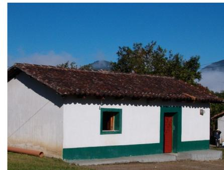
*Un ejemplo más de vivienda de adobe recubierto el exterior con aplanado cem-cal-arena para su protección, y cubierta a dos aguas con teja de barro, localidad “Cañitas”, municipio de Ixtapa, Chiapas. Nótese la protección que se le da al rodapié a base de un color más oscuro que el resto de la fachada para ocultar las salpicaduras cuando llueve*
