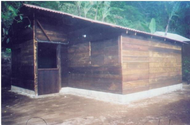
*Vivienda de madera construida por el INVI, tratada con diesel y chapapote y cubierta con lámina de fibrocemento, libre de asbesto; en la “Sierra Mam”, municipio de Tapachula, Chiapas.*
