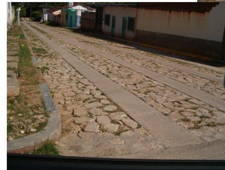
*Otro de los usos que tiene la piedra es en la pavimentación de calles, en la imagen se aprecia un pavimento mixto entre piedra y concreto simple.*
