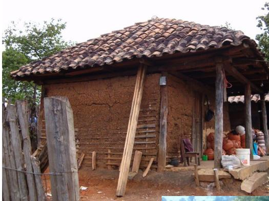
*Bajareque tradicional con encetado a base de madera (izquierda) y corredor a base de horcones y cubierta a cuatro aguas con teja de barro, (abajo) con corredor semicerrado, en la cabecera municipal de Amatenango del Valle, Chiapas.*
