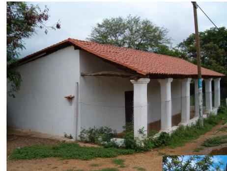
*Típico corredor en un clima cálido de la Ribera de Cupía, en el municipio de Chiapa de Corzo, construido con muros de adobe y aplanado fino con pintura a la cal, vigas de madera y cubierta con teja de barro rojo recocido*
