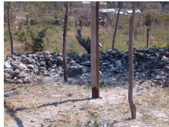
*“horcones” de madera característicos para la construcción de este tipo de viviendas, en muchas ocasiones faltos de seguridad y estabilidad estructural.*
