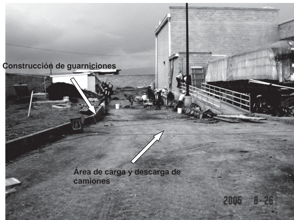
Foto III.6.2.1 Trabajos previos al colado.
