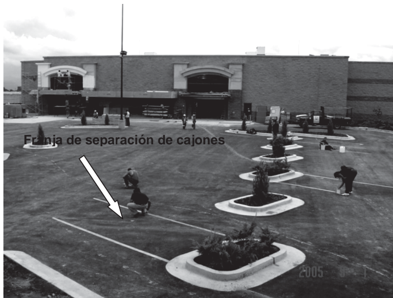
Foto III.6.3.2 Pintado manual de señalamiento horizontal.
