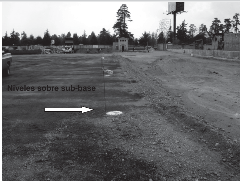
Foto III.2.2.12 Niveles de sub - base terminada.
