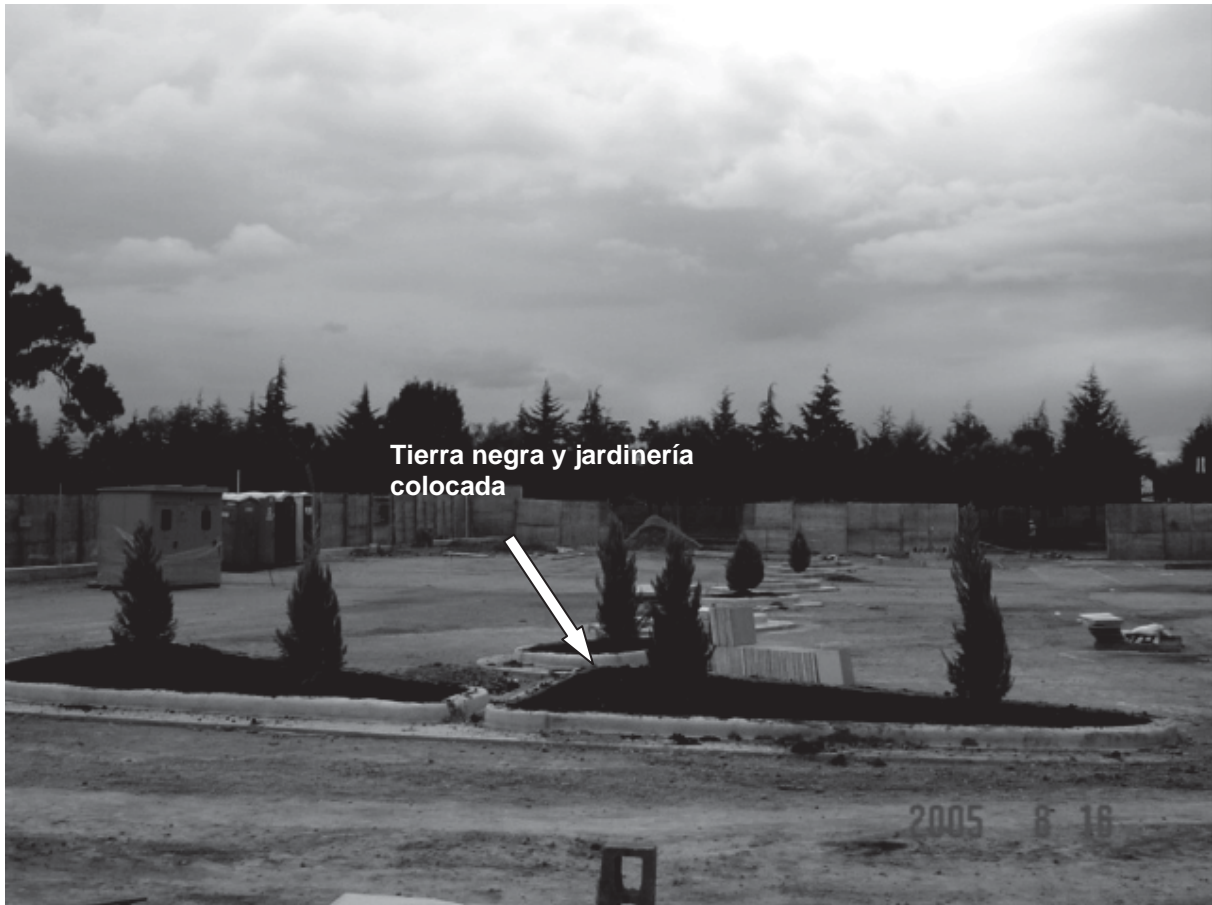
Foto III.6.1.2 Se observa la jardinería colocada antes de la pavimentación.
