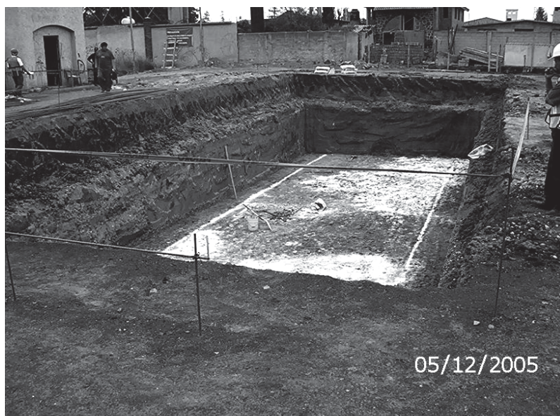
Foto. III.4.4.1 Excavación del cajón y estabilizado con cal.
