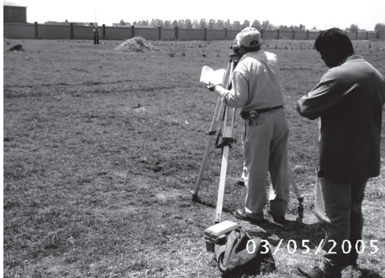
Foto. III.1.2.1 Trazo de los ejes de proyecto.
