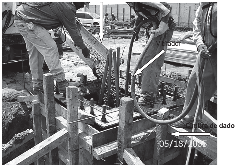
Foto III.3.3.2 Colado y vibrado de zapata.
