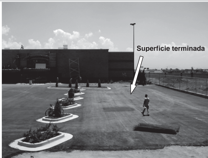
Foto III.6.1.13 Vista de la carpeta asfáltica después de haber sido sellada.
