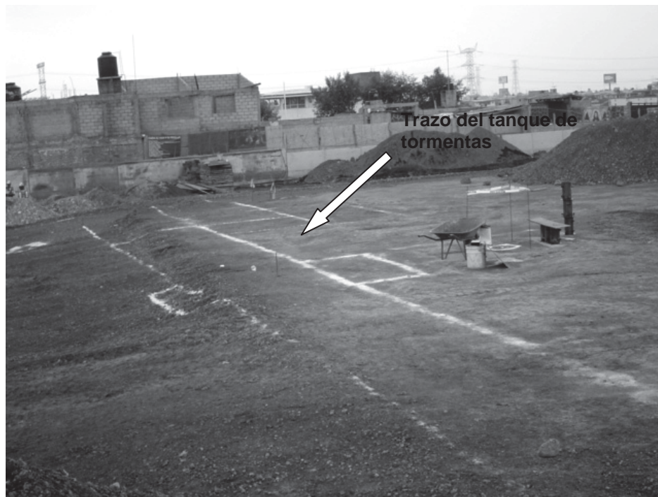
Foto. III.1.2.2 Señalamientos con cal.
