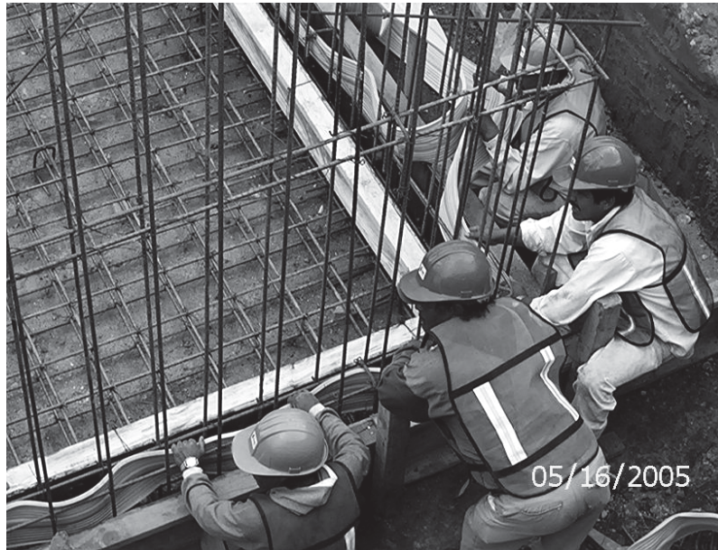
Foto III.4.4.6 Colocación de la banda de PVC.
