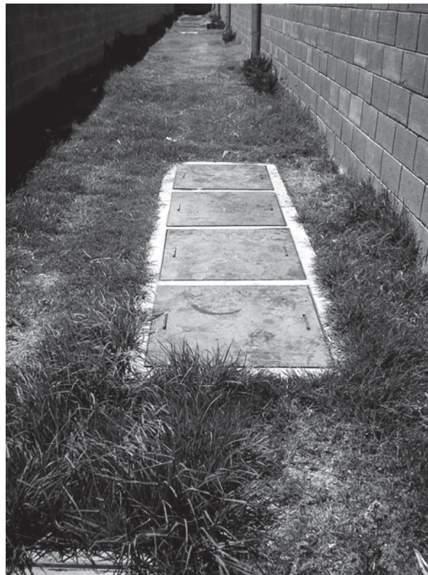
Foto III.4.2.3 Trampa de grasa terminada.
