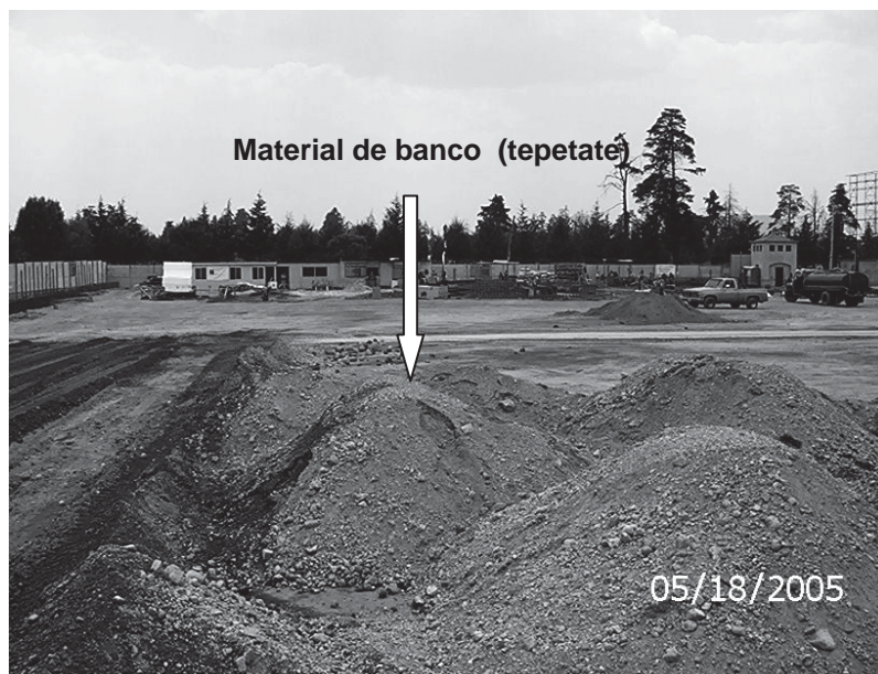
Foto III.2.2.4 Material para el relleno.
