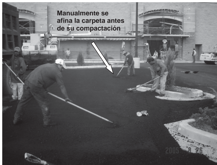
Foto III.6.1.7 Trabajadores afinando la carpeta.
