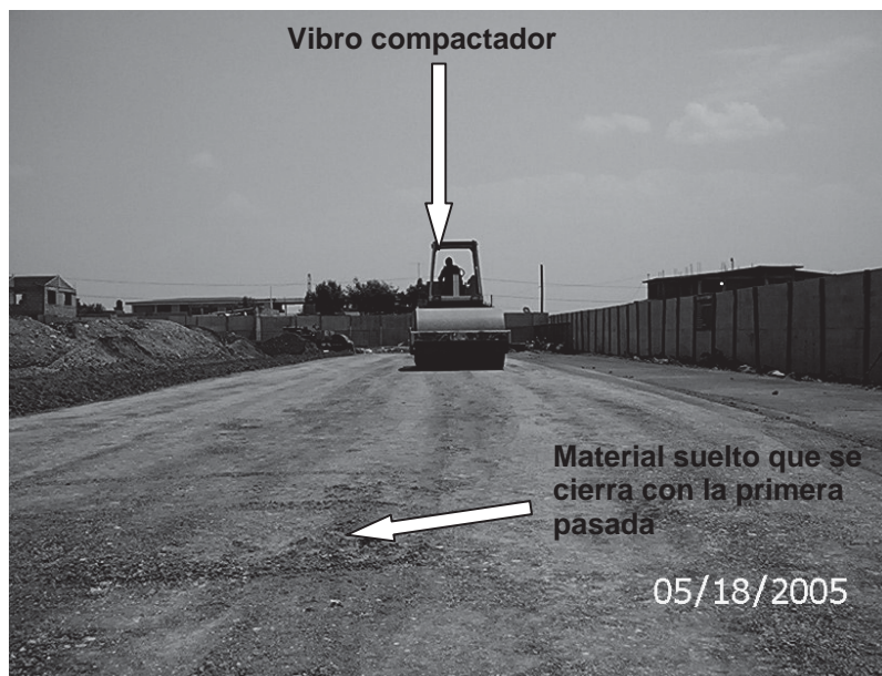
Foto III.2.2.11 Compactación y acabado final.
