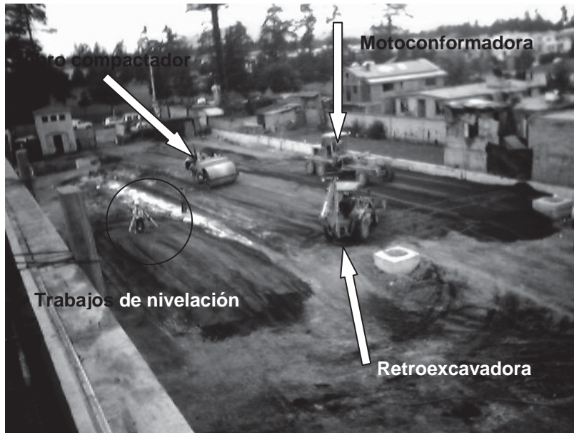
Foto III.2.2.1 Se aprecia el trabajo coordinado de los equipos.
