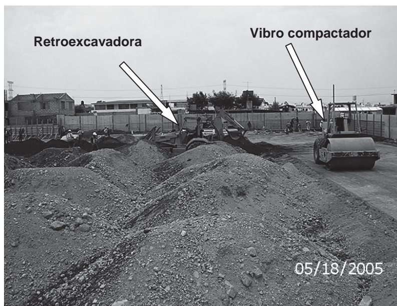
Foto III.2.2.2 Coordinación de la maquinaria.
