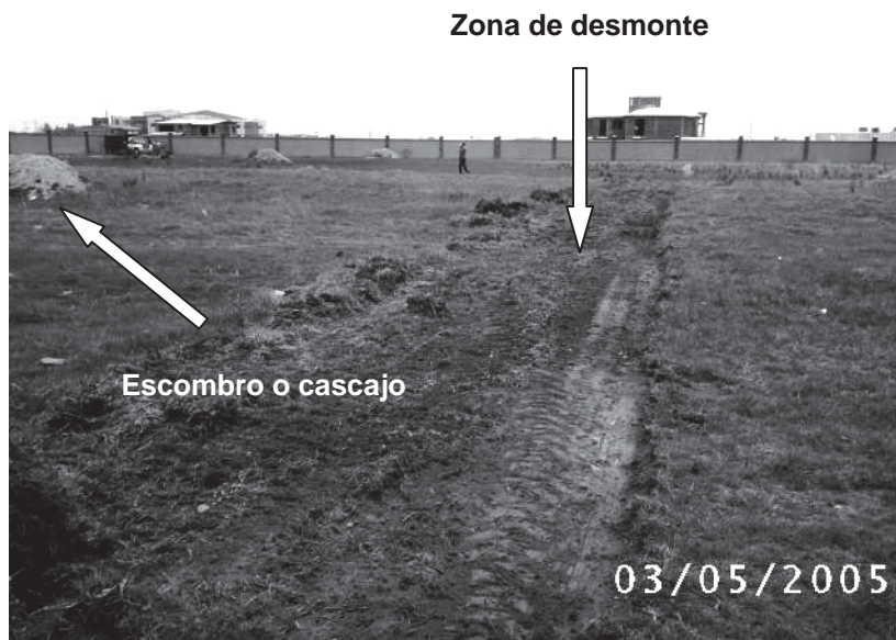
Foto III.2.1.4 Retiro de vegetación y cascajo.
