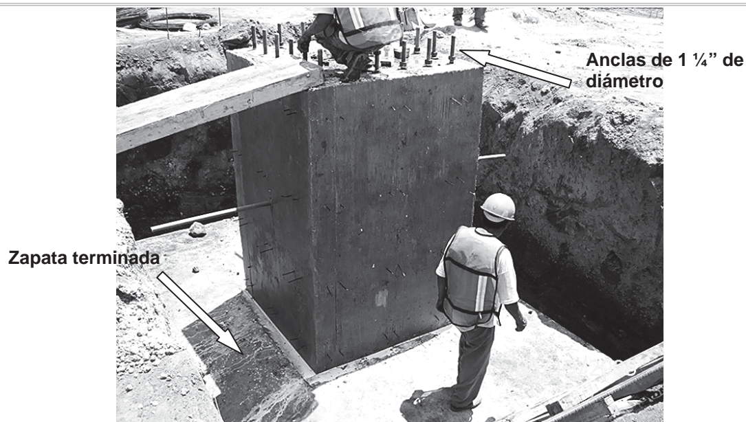
Foto III.3.7 Zapata terminada.
