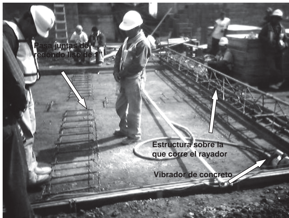
Foto III.6.2.3 Supervisión final antes de iniciar el colado.
