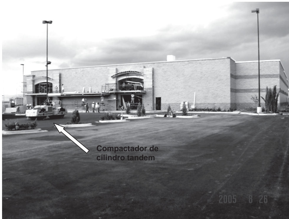
Foto III.6.1.8 Se aprecia el momento de compactación del asfalto.
