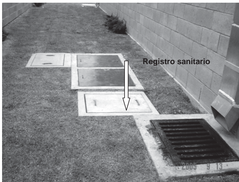
Foto III.4.2.2 Registro sanitario terminado.
