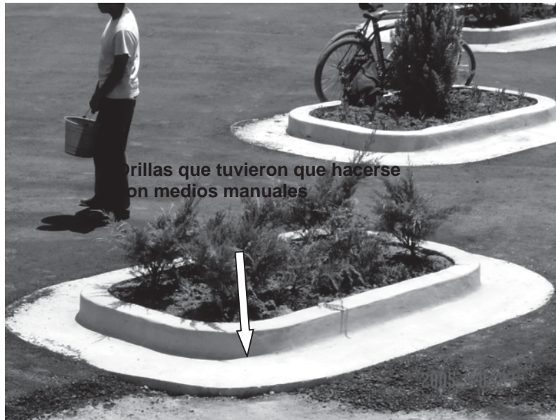
Foto III.6.1.11 Se aprecia los detalles que tuvieron que hacerse a mano.
