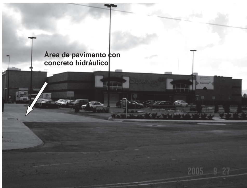
Foto III.6.2.8 Pavimento de concreto hidráulico ya terminado.
