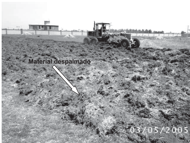
Foto III.2.1.1 Trabajos de despalme.
