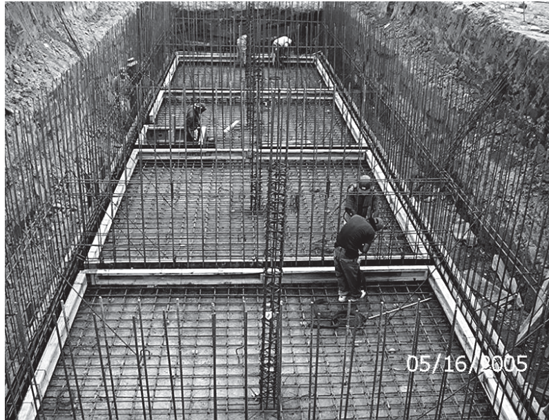
Foto III.4.4.4 Habilidad de acero de refuerzo en la losa de fondo.
