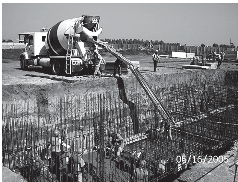
Foto III.4.4.5 Colado de la losa de fondo.
