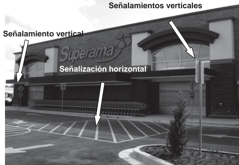
Foto III.6.3.1 Se aprecian las señalizaciones horizontales y verticales.
