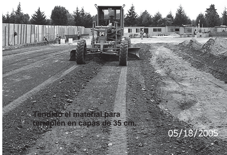
Foto III.2.2.7 Tendido de material.
