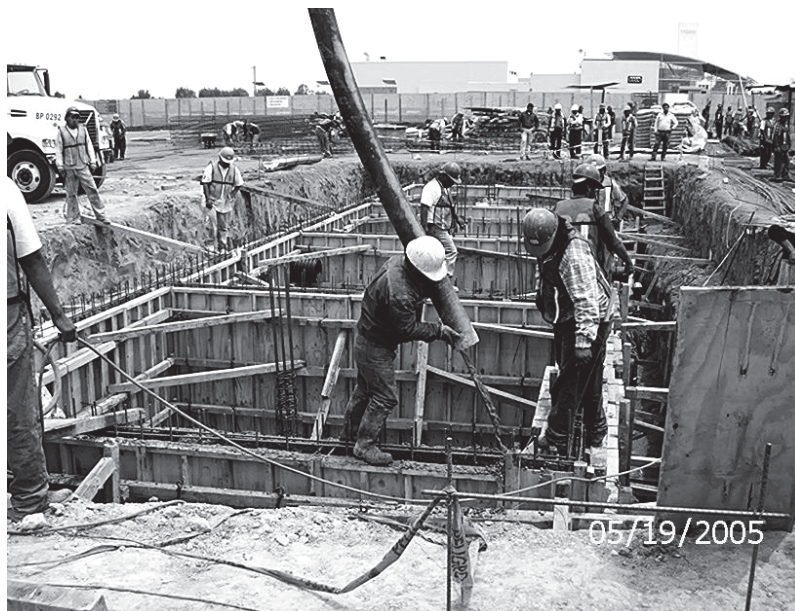
Foto III.4.4.9 Proceso de colado de los muros del tanque.
