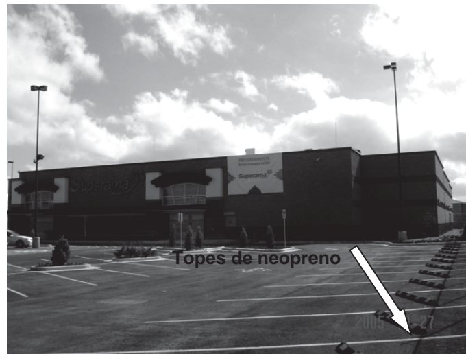
Foto III.6.3.4 Vista del estacionamiento ya terminado.
