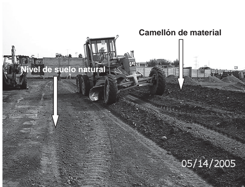
Foto III.2.2.6 Preparación del camellón para agregar agua al material.
