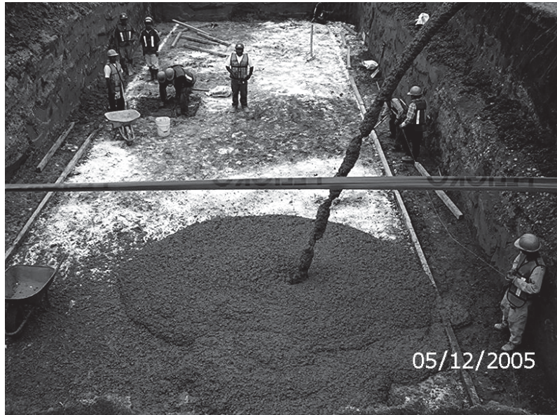
Foto III.4.4.2 Colado de plantilla de concreto.
