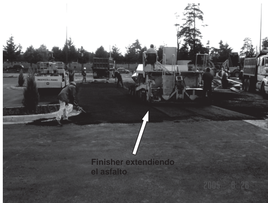
Foto III.6.1.5 Se observa como se va colocando el asfalto.
