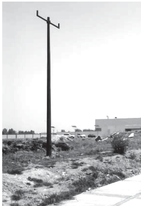
Foto. III.1.3.1 Poste cónico que se desmontó.
