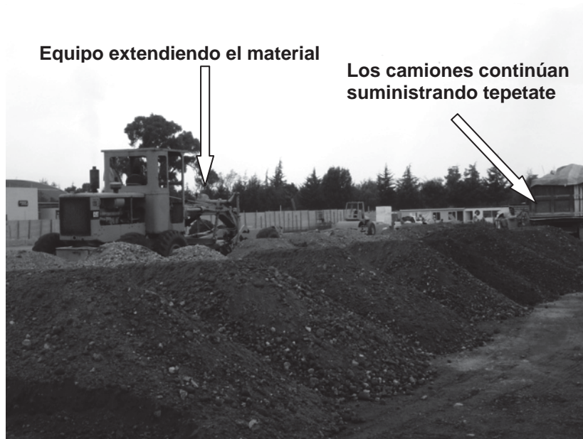
Foto III.2.2.3 Construcción de terraplén.
