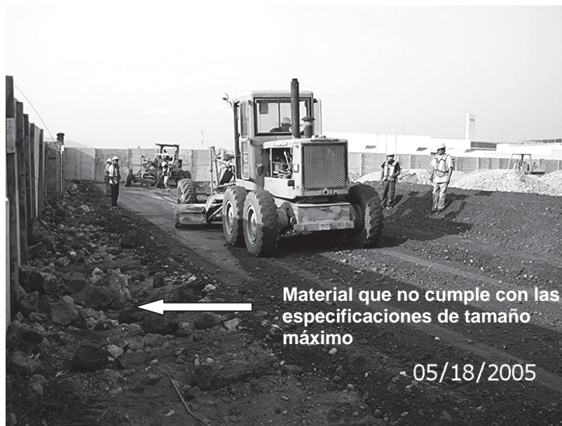
Foto III.2.2.9 Se aprecia la selección y tendido de material.
