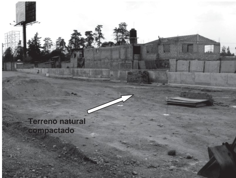
Foto III.2.1.5 Terreno natural recién compactado.
