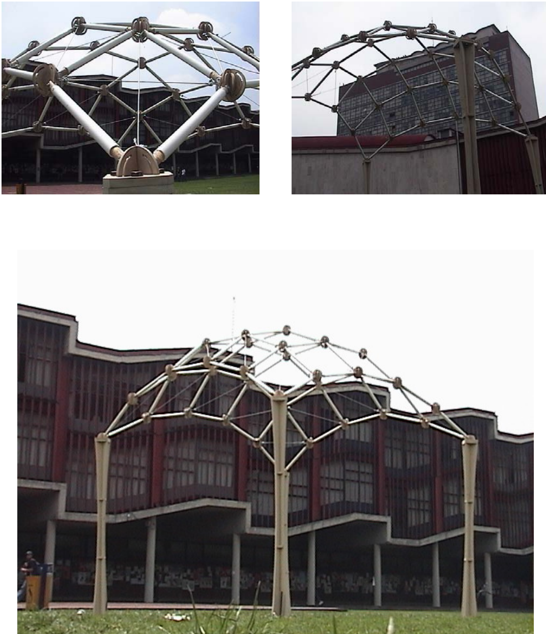
Fig. 5.16 Prototipo con curvatura sinclástica escala 1:1 fabricado con nodos de MDF (Middle Density Fiber), conectores de madera, barras de PVC, cables de refuerzo diagonales de acero galvanizado y una cubierta de tela.
