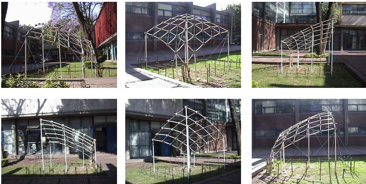
Fig. 5.13 Armado de un cuarto de cubierta del prototipo escala 1:1.
