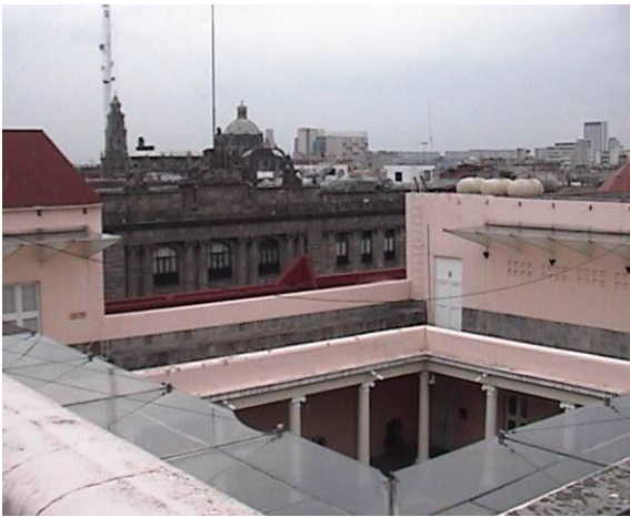
Fig. 4.1 Vista del patio por la azotea
