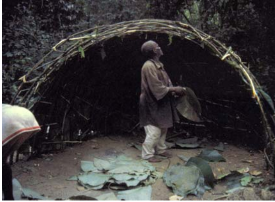
Fig. 2.2 Construcción tribal formada por amarres de varas en África. Fuente: Alejandro Bacón, Arquitectura Textil.
