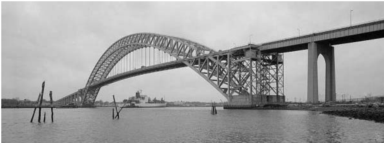
Fig. 2.22 Puente Bayonne sobre el estrecho Kill van Kull, Nueva Jersey, EU, 1931. Fuente: statenislandtalk.com
