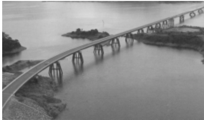
Fig. 23. Puente Chiapas, Costa del Golfo de México, 2003, 1800 m de longitud, acero
