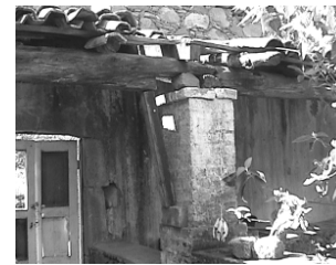
F.24 Pilar de sección cuadrada de tabique, agregada durante el siglo XIX, pintada de color rojo con pintura de cal.
