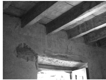
Entrepiso con tablonos machimbrados
