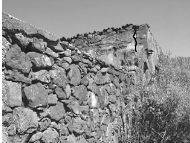
Separación de fachada y tendencia a volteo
