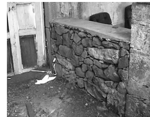
F.25 Murete agregado, rompiendo con la circulación continua de origen en torno al patio central
