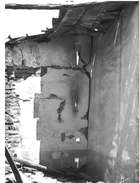
Separación de fachada y tendencia a volteo
