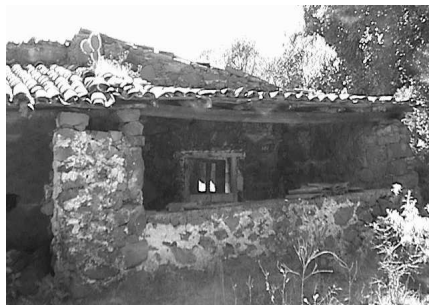
Pórtico de acceso (portal) f.03
