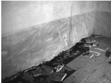
Piso de barro sobre relleno de terreno natural
