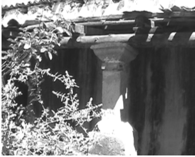
Pilar sustituido parcialmente
