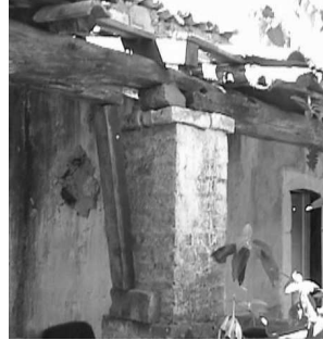
Pilares sustituidos totalmente
