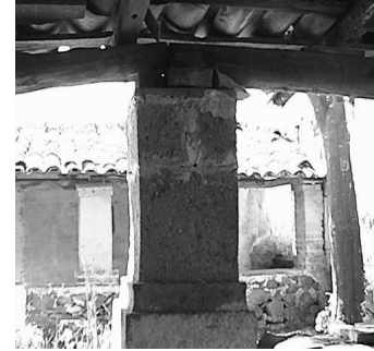
Pilares sustituidos totalmente
