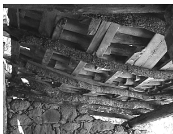
F.12 y F.13 Sistema de cubierta dañado, morillos sustituidos con flambeo, falta de apoyo en viga maestra (mechinal), teja infectada.
