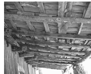
F.26 Sustitución de vigas de madera de encino, por morillos de sabino.
