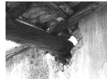
DETALLE EMPOTRE DE VIGA HORIZONTAL ESCALA 1:50
