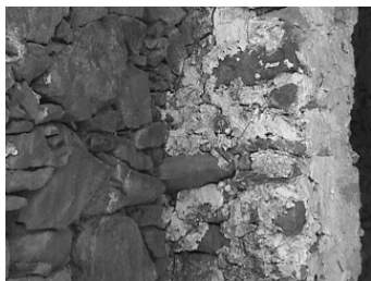
Muro de adobe con aplanado
