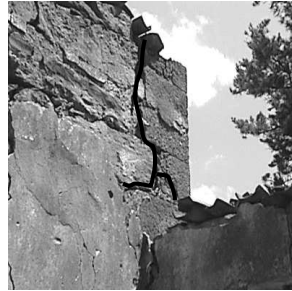
Separación de fachada y tendencia a volteo
