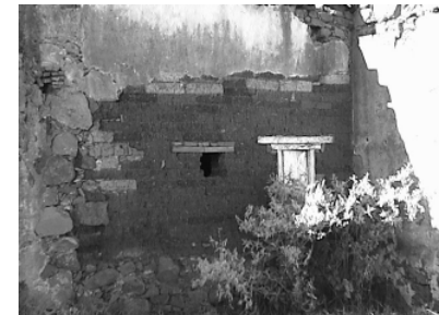
Muro de adobe
