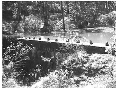
Presa de abastecimiento
