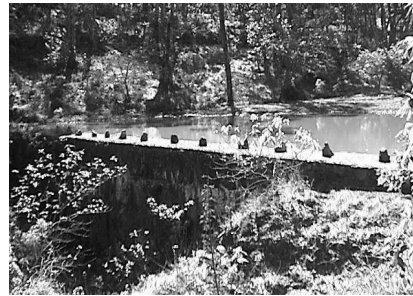
Presa de abastecimiento
