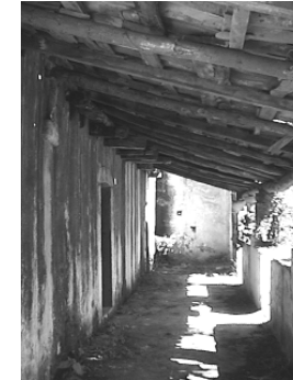
Deambulatorio interior. Estado actual
