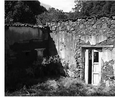
Pórtico interior (portal) f.11
