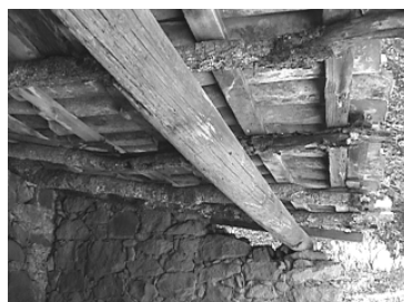
F.12 y F.13 Sistema de cubierta dañado, morillos sustituidos con flambeo, falta de apoyo en viga maestra (mechinal), teja infectada.
