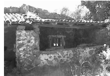
F.23 Murete agregado en pórtico de acceso, para adaptarlo como chiquero (1980 aprox) Murete de piedra de pepena, unido con mortero de cemento arena.
