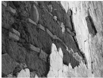
Muro original y agregado
