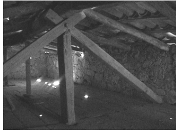
Estructura de madera en tapanco
