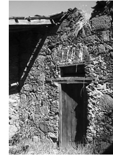
F.06 Falta de aplanado, disgregación de material en muro, colapso de cubierta, vegetación parásita en muro y piso, puerta sustituida.
