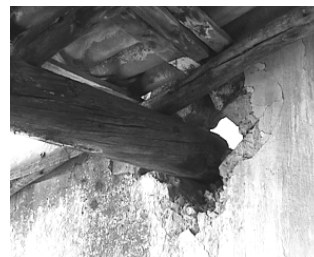
F.15 Mechinales disgregados, fisuras en muro, cubierta dañada.
