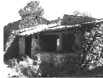
Pórtico de acceso principal. Estado actual.
