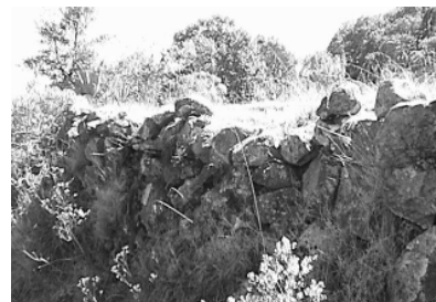
Mampostería en muretes de contención
