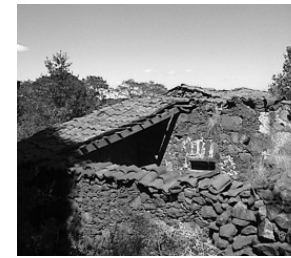
F.06 Falta de aplanado, disgregación de material en muro, colapso de cubierta, vegetación parásita en muro y piso, puerta sustituida.
