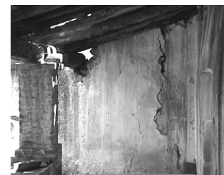
F.15 Mechinales disgregados, fisuras en muro, cubierta dañada.
