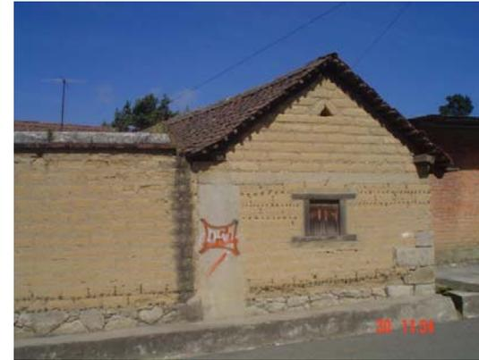
En las fotos (superior e inferior) se muestra el uso de materiales de construcción como el adobe, la piedra braza y el tabique de barro rojo recocido en muros, así como el empleo de techos inclinados a dos aguas con teja de barro tipo caña y ventanas de carpintería y herrería, que es lo más común en la población.
