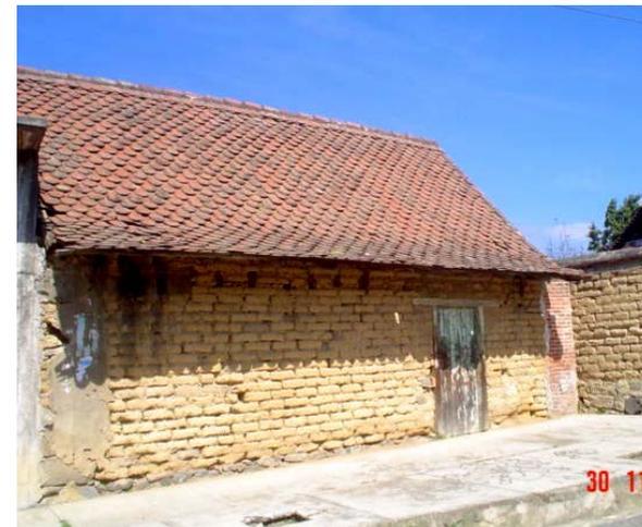
Fachada Sur de un inmueble en Amecameca Méx., fotografía tomada el día 30 de diciembre del 2005 a las 12:00 hrs., muestra claramente el desperdicio de la radiación que se recibe en invierno, debido a que las ventanas en este caso tienen orientación Norte.
