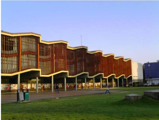
La imagen (arriba) muestra parasoles de tipo vertical, en el edificio de posgrado en Arquitectura de la UNAM, era una buena solución pero requería de mantenimiento especial y continuo, con el tiempo las lamas se solidificaron en mala posición por falta de mantenimiento, induciendo enormes dificultades térmicas al interior de las aulas.
