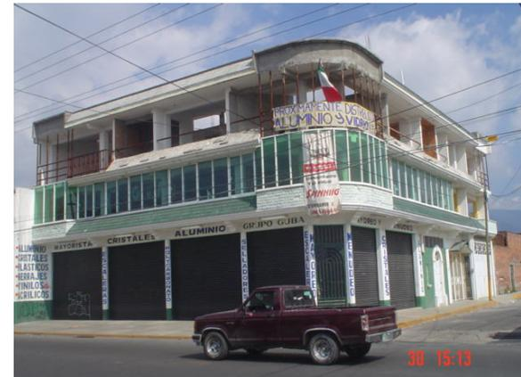
Casa en esquina con orientación sur-oeste, con inconveniente de sobrecalentamiento debido al gran acristalamiento, donde se aplico un correctivo que consiste en persianas interiores horizontales, para reducir la irradiación solar.
