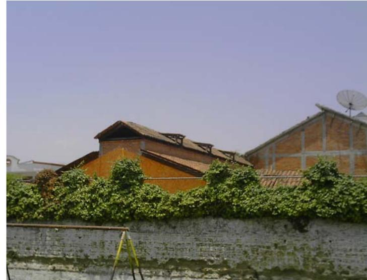
Solución bioclimática efectuada en un jardín de niños en Amecameca, México, el inmueble presentaba problemas de alta temperatura interior por sobrecalentamiento y falta de ventilación, la corrección es perfectamente visible por el cambio en el acabado de la fachada principal.
