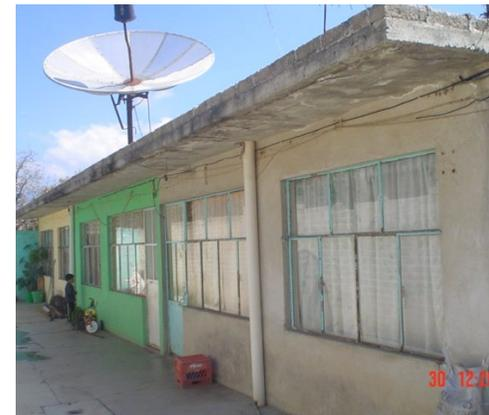
Izquierda; viviendas con techumbre de losa de concreto armado y tabicón, con un acabado en repellado rustico, fachada poniente y ventanearía de herrería.
