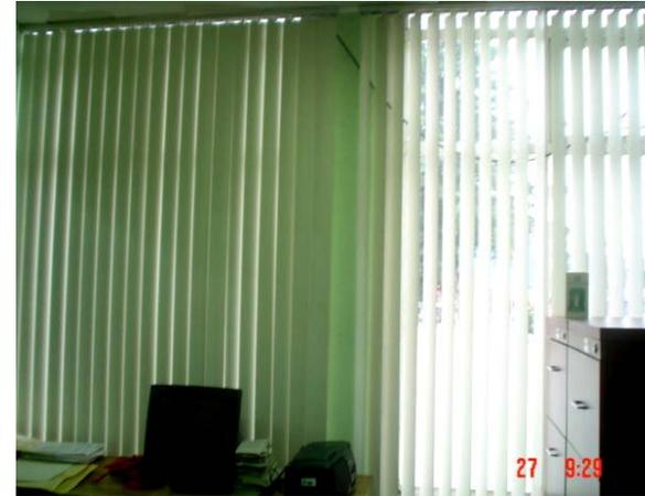
La imagen muestra como solución bioclimática; protecciones solares móviles internas, (plegables) se puede manipular el acceso de la radiación solar a placer, regulando de este modo la temperatura al interior y también controlar la intensidad de la iluminación en el recinto.
