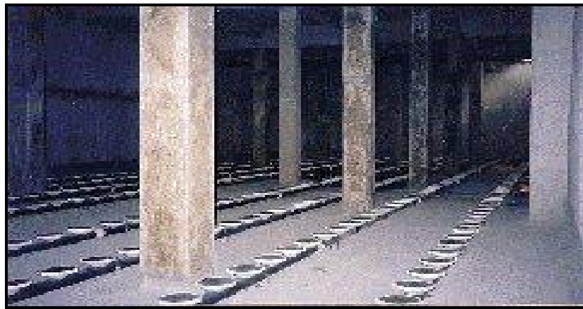
FIGURA 6 Biofiltro con difusores sumergidos
