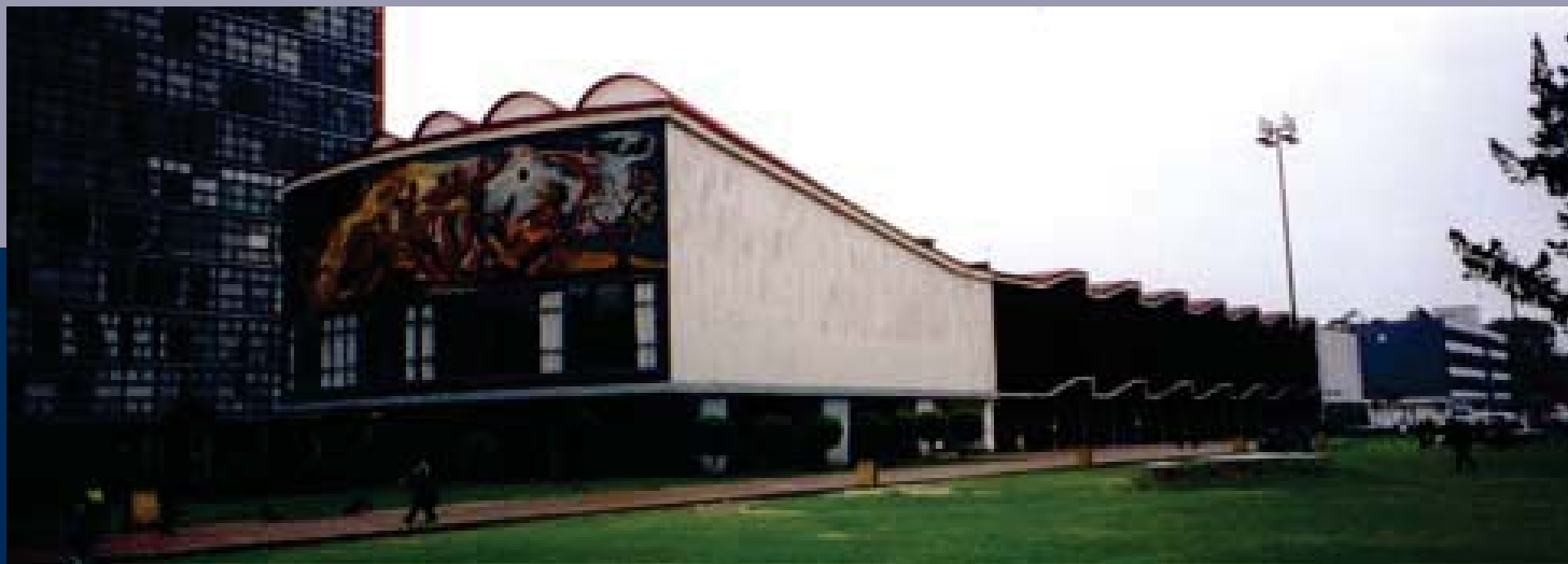
FIGURA 5. FACHADA DEL POSGRADO DE ARQUITECTURA
