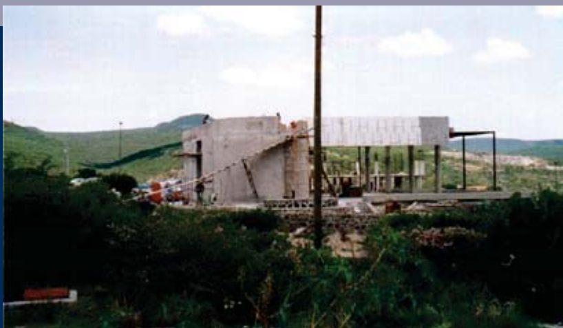
FIGURA 39. OTROS SERVICIOS EN CONSTRUCCIÓN (CAFETERÍA)
