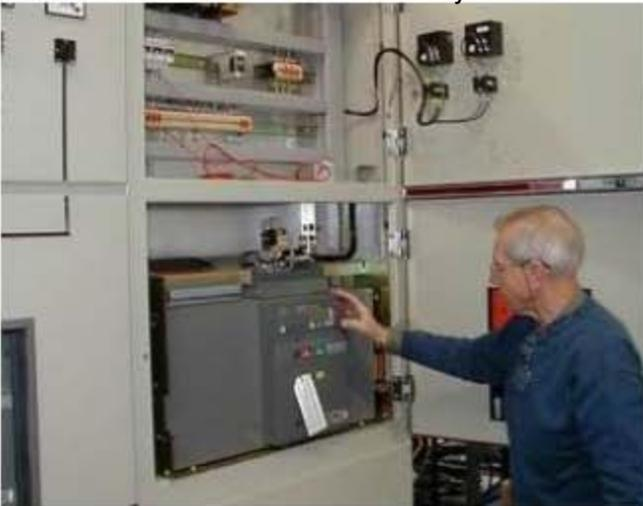
**5.3.9 Interruptores derivados de Baja Tensión.-** Pueden ser de navajas, termomagnéticos, arrancadores o centros de control de motores y tableros de alumbrado según sea necesario.
