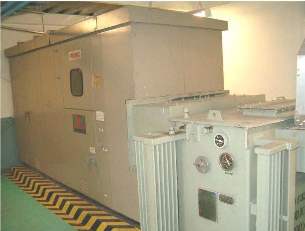
**Figura 5.1-a. Subestación eléctrica compacta**
