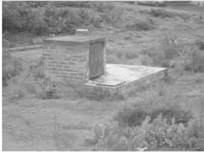
Foto 9. Cisterna acometida de agua.
