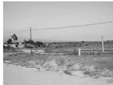
Foto 13. Poste de teléfono y señalamiento de tubería de gas LP.
