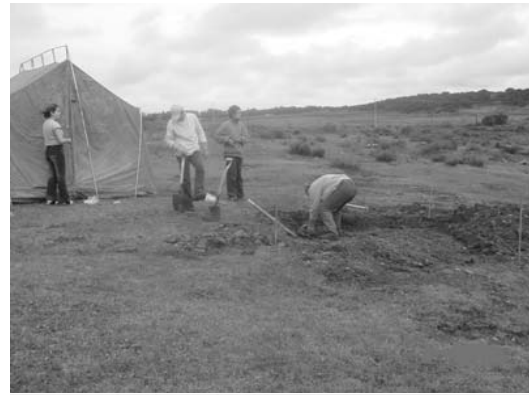
Pozo a cielo abierto para constatar la consistencia del terreno
