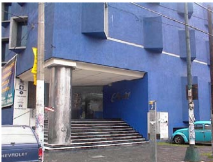
LA ESCUELA CONSTA DE TRES NIVELES, Y ESTACIONAMIENTO A CUBIERTO.
