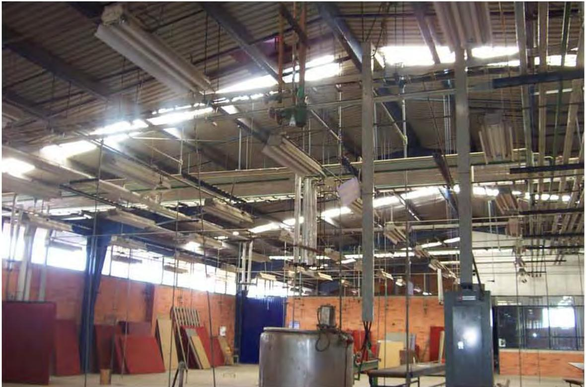
*Fotografía 5.9. Parte de las luminarias del interior de la nave, están en buen estado y todos funcionan.*
