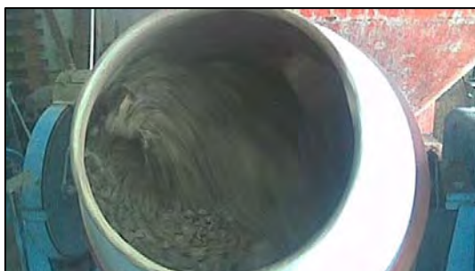
Fig. 2.1 Mezclado de concreto en revolvedora.
