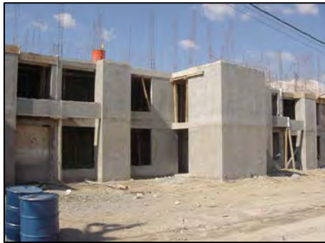
Fig. 5.8 Obra negra de conjunto habitacional
