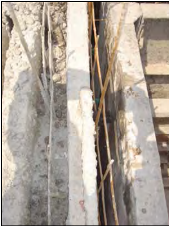
Fig. 3.7 Muros de concreto de baja resistencia de ancho 10 cms.
