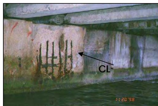
Fig. 4.12 y 4.13 Ataque del ión cloruro en el concreto en distintas obras con acero de refuerzo
