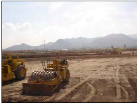
Fig. 5.4 Trazo, desmonte, despalle y nivelación de terreno a construir.
