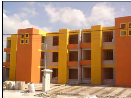
Fig. 5.9 Vivienda de interés social concluida
