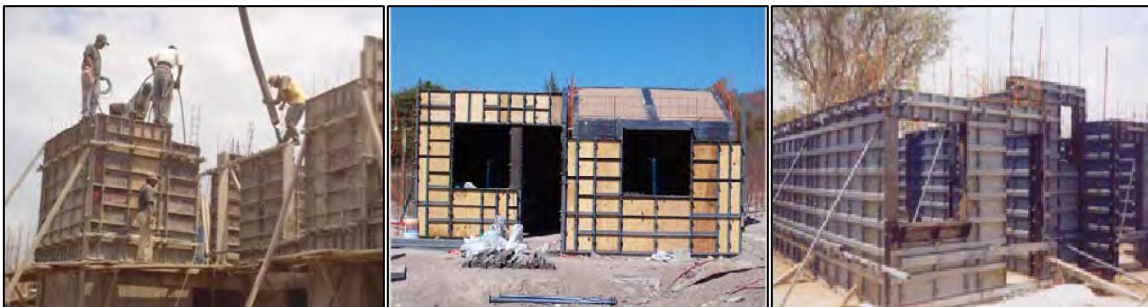
Fig. 5.13 Moldes metálicos para concreto monolítico en muros y losas en Viviendas de interés social.
