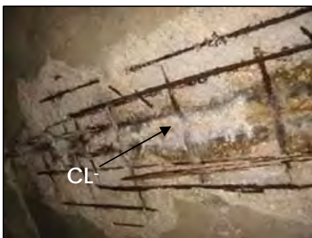
Fig. 4.12 y 4.13 Ataque del ión cloruro en el concreto en distintas obras con acero de refuerzo
