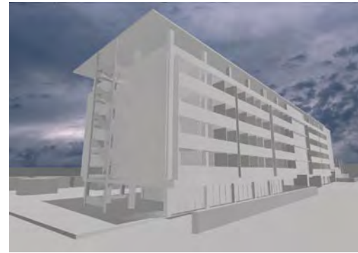
edificio de vivienda
