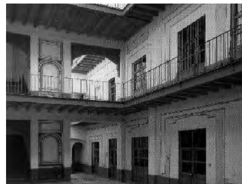
Edificio de vivienda restaurado.
