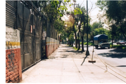
F4. Es notorio el estado actual del sitio
