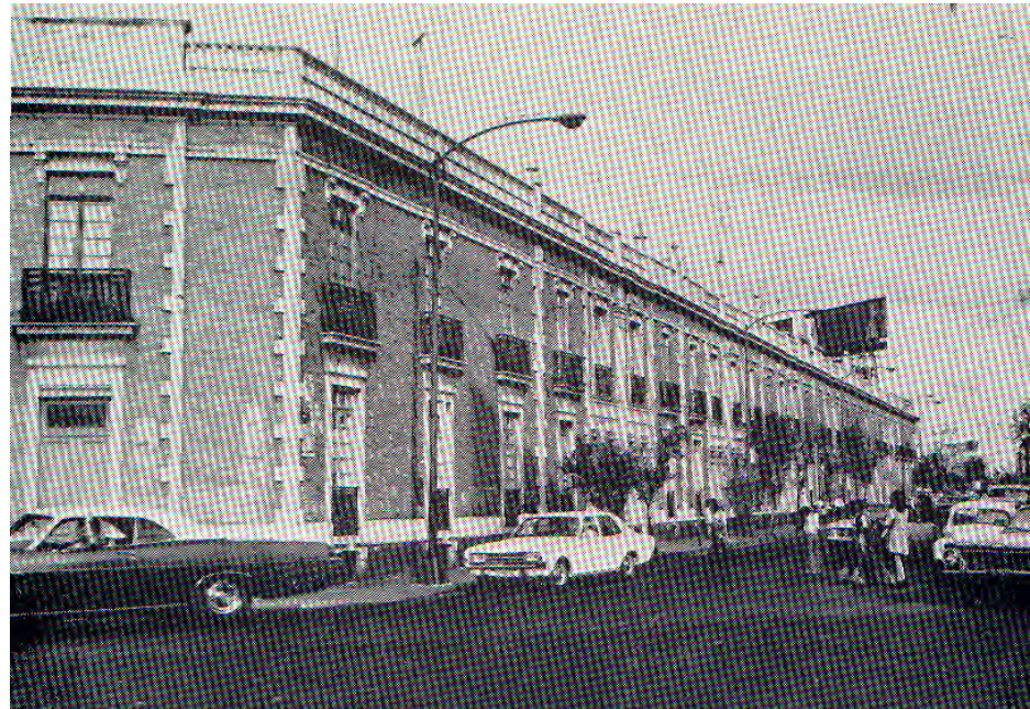
24. Conjunto Buen Tono, ubicado al final del Paseo de Bucareli.
