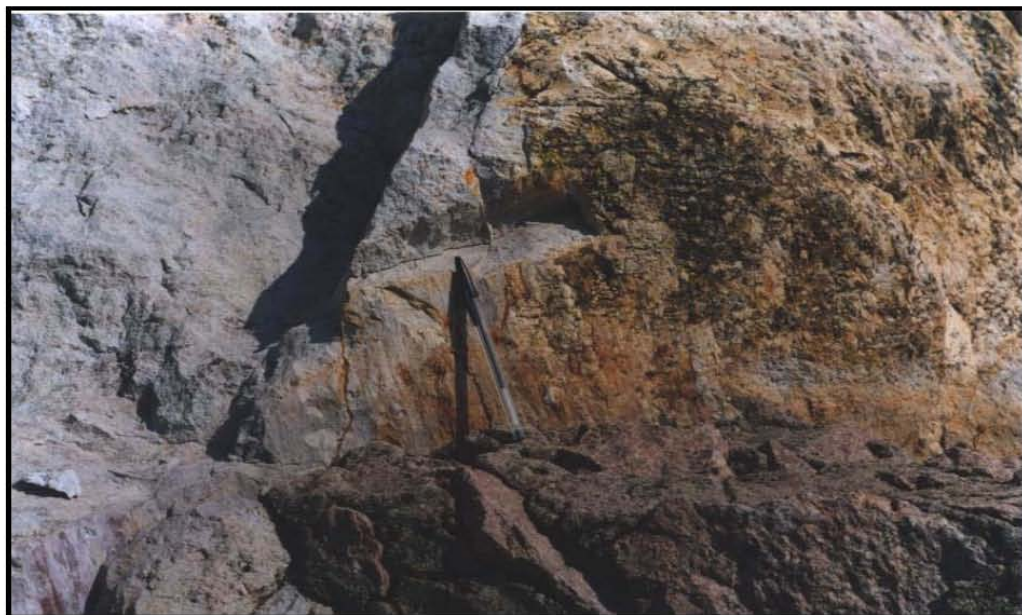
Figura 33. Plano de falla sobre la traza de la Falla Presa de Rayas en la presa Los Pirules.
