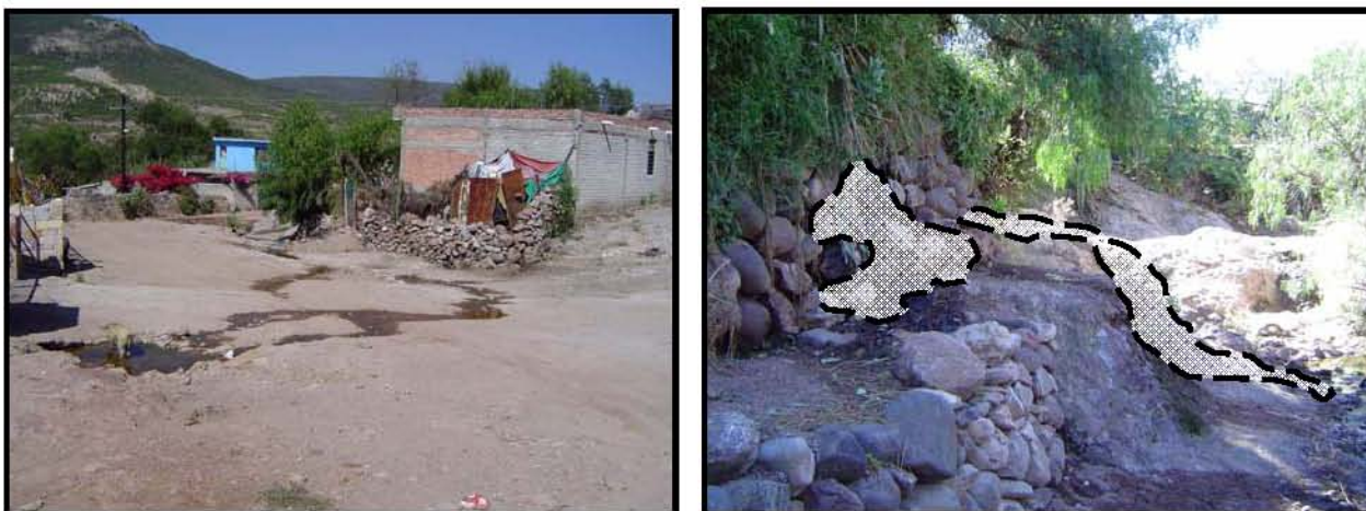
Figura 15. 2 casos en los que hay problemas con las aguas residuales. A la izquierda se muestra una fuga por rotura en la tubería. A la derecha se señalan con los polígonos, los sitios donde son vertidos las aguas negras producidas por hombres y animales de la vivienda, en uno de los casos el flujo alcanza el cauce. Santa María de los Baños.
