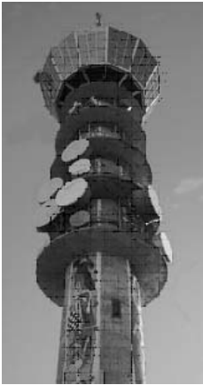
Figura I -1. Torre de Telecomunicaciones
