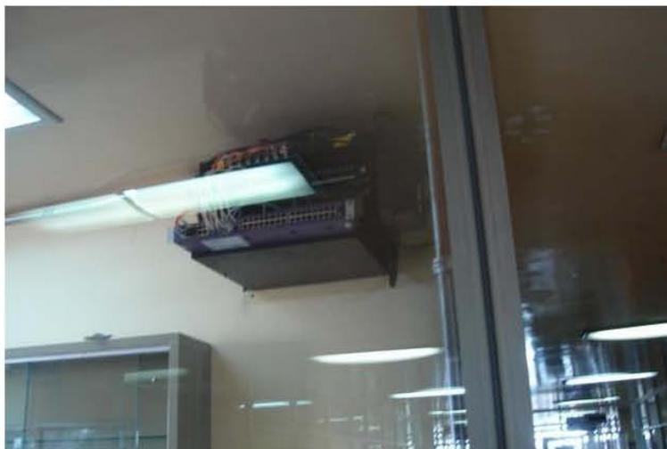
Figura 5.18. Punto de acceso inalámbrico en modo puente.
