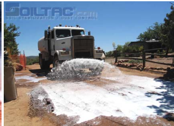
b) Mezcla de cal en forma de lechada
