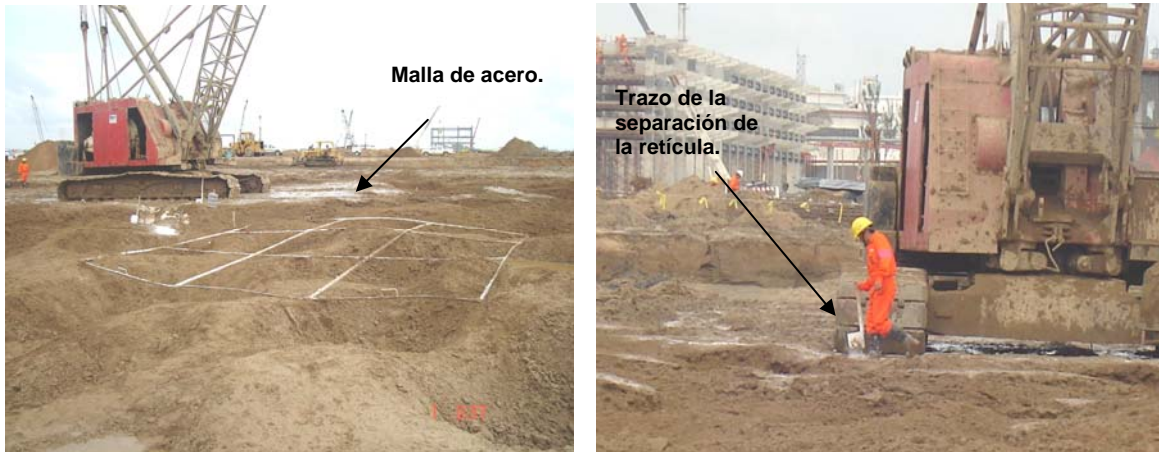
Fig. 5,17 Colocación y trazo de la cuadrícula para el inicio de cada fase.
