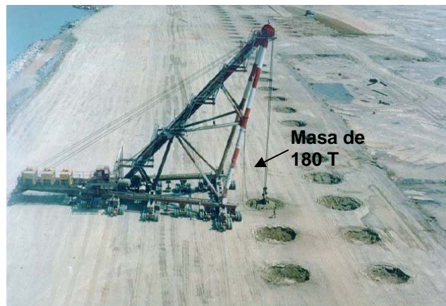
Fig. 4.14 Trípode utilizado en los trabajos de compactación dinámica.
