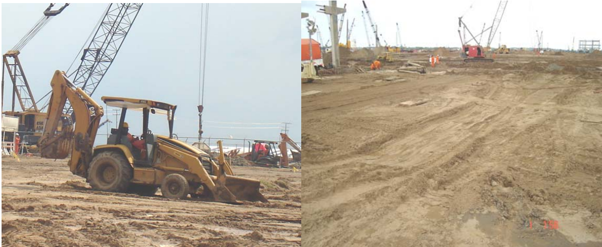
Fig. 5,16 Preparación de una plataforma estable.
