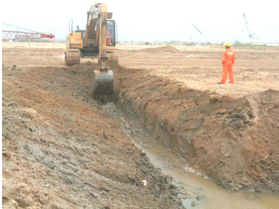
Fig. 5,20 Excavación de zanja para conducir el agua.
