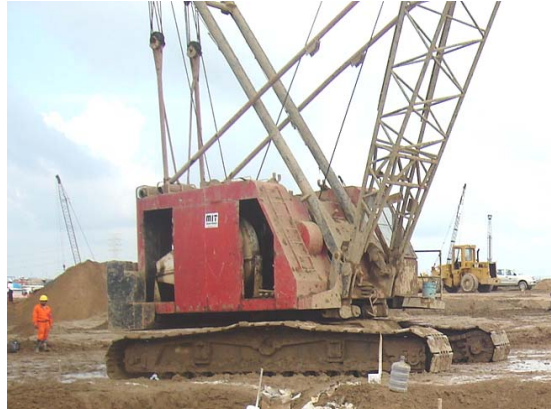
Fig. 5,19 Placa de acero y grúa utilizada para los trabajos de compactación dinámica.
