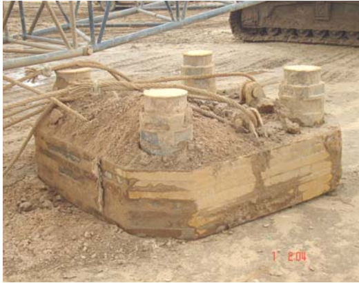
Fig. 5,19 Placa de acero y grúa utilizada para los trabajos de compactación dinámica.
