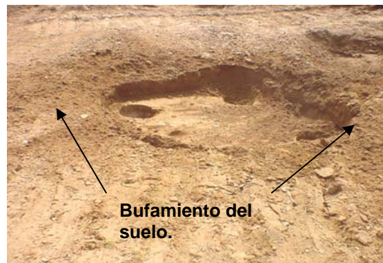
Fig. 3.4 Esfuerzo del suelo adyacente a los cráteres.
