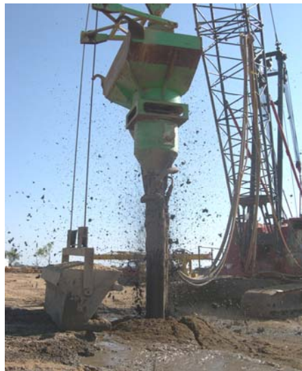
Fig. 1.10 Equipo de vibroflotación.
