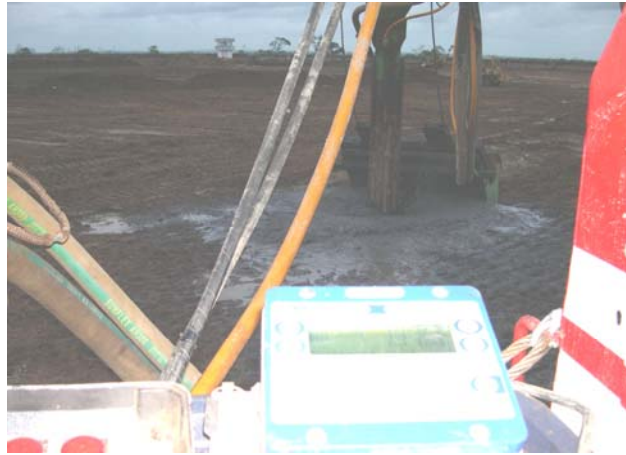
Fig. 1.12 Monitoreo de los trabajos de vibroflotación
