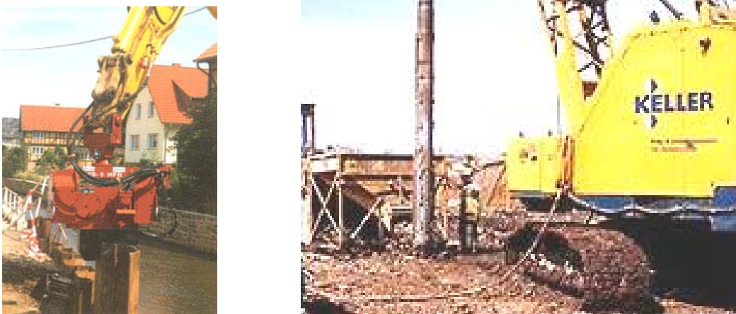
Fig. 1.13 Equipo requerido para los trabajos.
