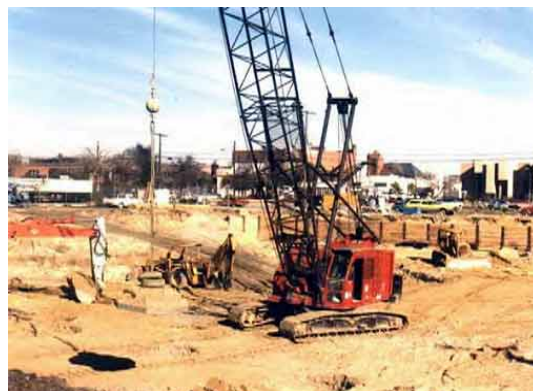
Fig. 4.7 Trabajos de compactación dinámica cerca de estructuras
