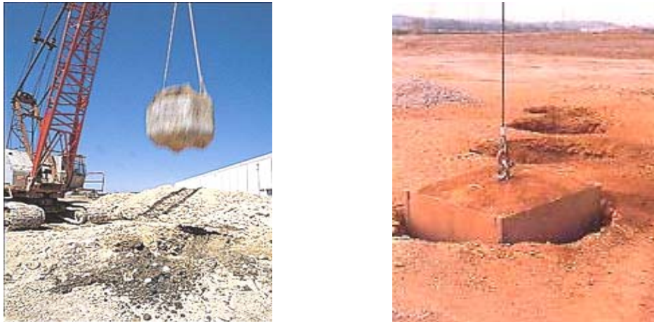
Fig. 1.17 Trabajos de compactación dinámica.
