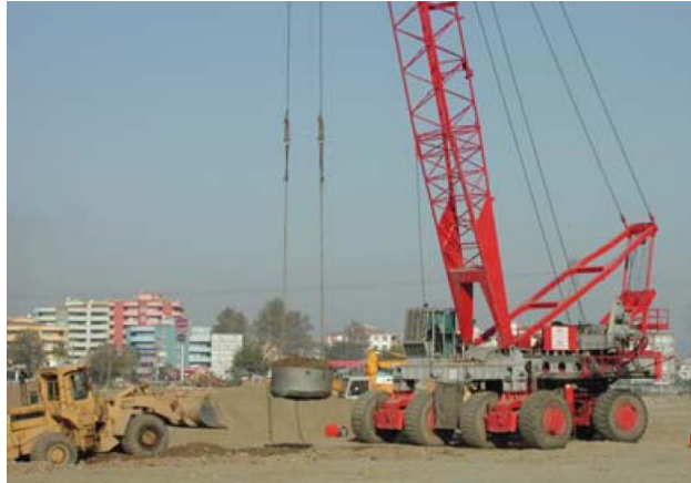
Fig. 4.15 Masa de 18 t altura de caída 25 m.
