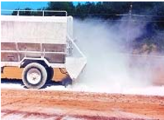
Fig. 1.2 a) Mezcla con cal a granel
