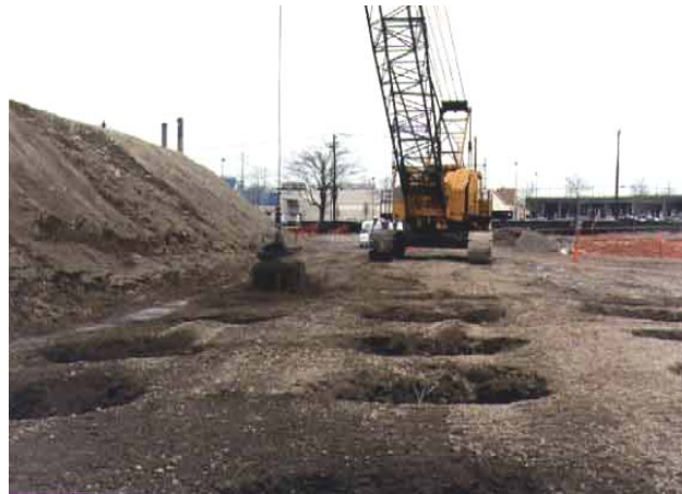
Fig. 4.4 Trabajos de compactación dinámica.
