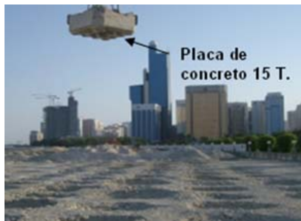
Fig. 4.17 Plataforma formada de un terraplén hidráulico.
