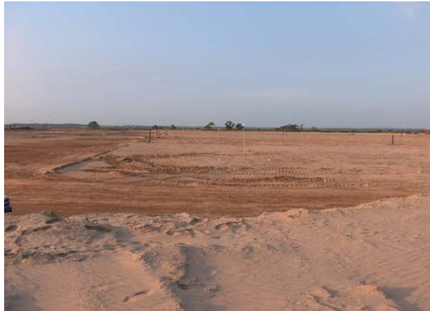
Fig. 1.5 Terraplenes de carga.
