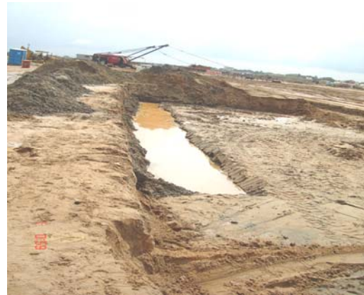
Fig. 5,20 Excavación de zanja para conducir el agua.
