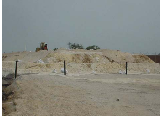
Fig. 1.6 Cuerpo del terraplén
