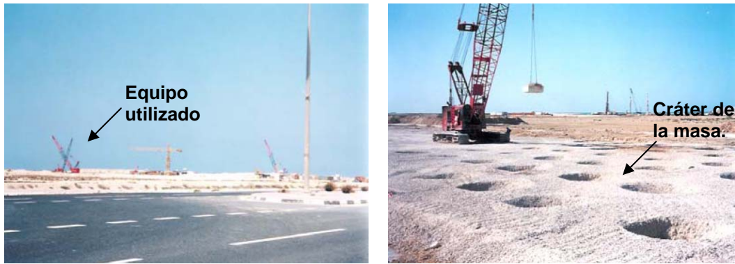
Fig. 4.13 Trabajos de compactación dinámica y huellas realizadas en el proyecto.
