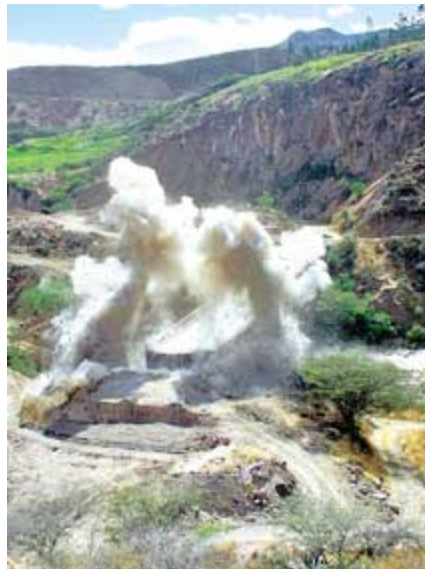
Fig. 1.7 Uso de explosivos
