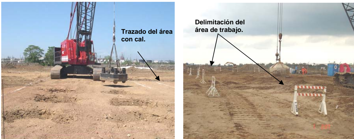
Fig. 5.24 Trazo y acordonamiento del área de trabajo.
