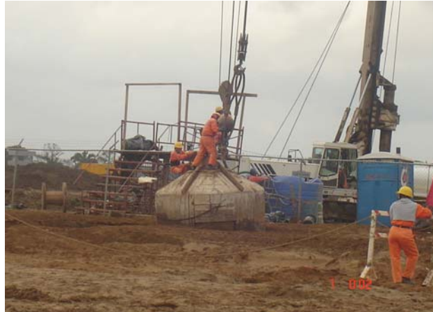
Fig. 4.3 Masa de concreto empleada para compactar el subsuelo
