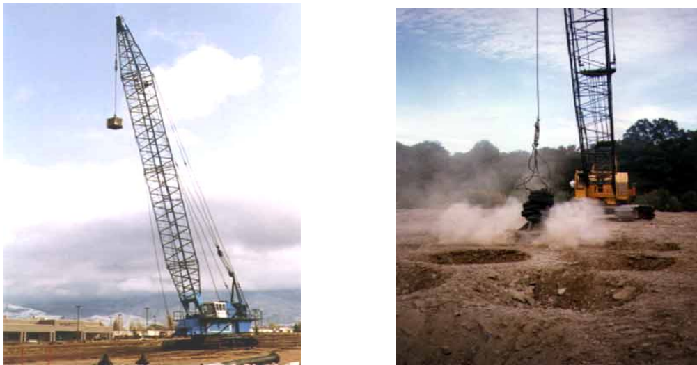
Fig. 4.8 Trabajos para mejora del sitio en la carretera.
