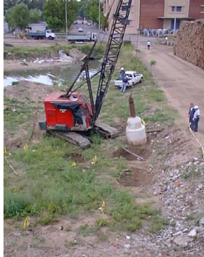
Fig. 2.10 Compactación dinámica sobre terrenos irregulares.
