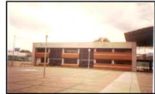
FOTO 3 Edificio de aulas
