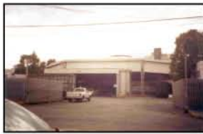
10 Interior del sitio
