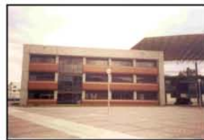
FOTO 5 Edificio de aulas
