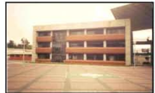
FOTO 9 Edificio de aulas
