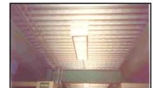
FOTO 15 Toma de la losa
