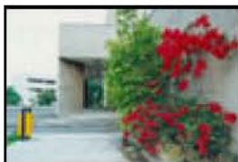
Edificio de Laboratorios
