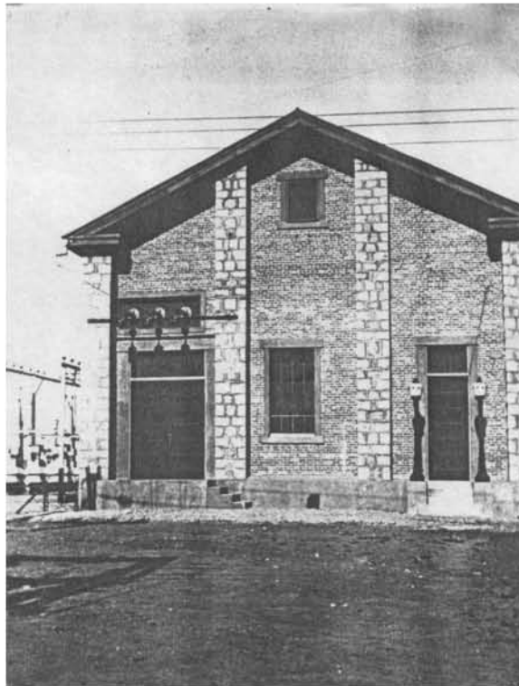
Fotografía 6. Subestación Morse (Chihuahua)
