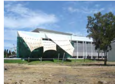
Vista de la oficinas administrativas de la Facultad de Arquitectura.
