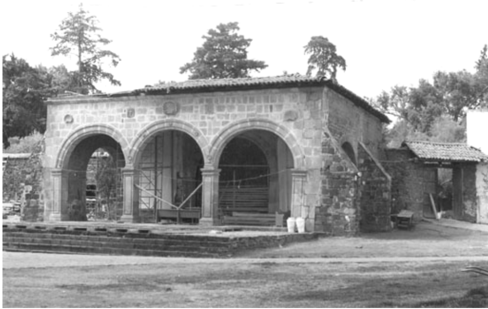
36. Capilla de hospital, a la derecha se mira la puerta que conduce al atrio principal. Convento de San Francisco, Tzintzuntzan (foto: V. Hernández, 2000).
