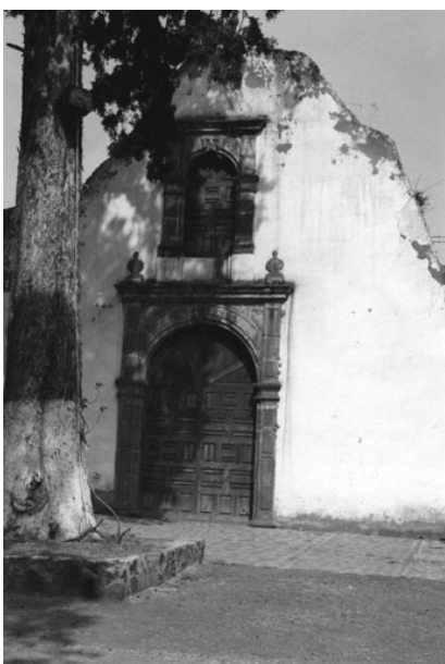
32. Fachada aislada. Convento de San Francisco, Tzintzuntzan (foto: V. Hernández, 2000).
