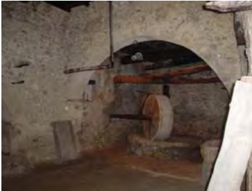
Imagen 54.- Edificio del antiguo molino: maquina en piedra de tradición animal del Siglo XVIII.
