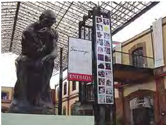
Imagen 129.- Vista del interior de la plaza Loreto en donde se muestra la cubierta de la estructura metálica que se colocó en el patio interior.
