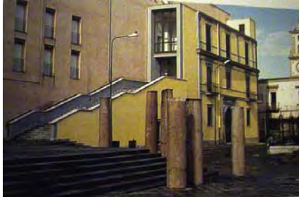
Imagen 42.- Acceso externo a sala conciliar
