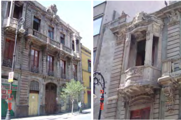
Imagen 134 y 135 Fachada del inmueble y detalle de la decoración de la misma.
