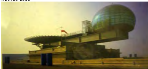
Imagen 28. Vista del helipuerto y de la sala de conferencias
