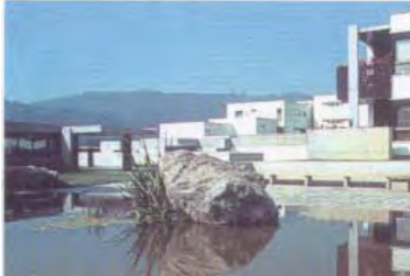
Imagen 147 Arroyo donde es vaciada parte de el agua pluvial recolectada
