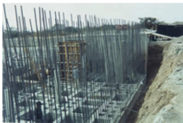
Imagen 148 se muestra la construcción in situ de una planta a base de elementos de concreto reforzado
