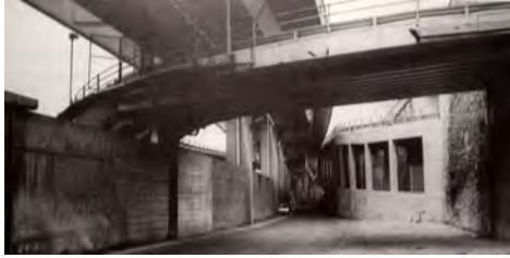
Imagen 65 que muestra uno de los múltiples espacios residuales que se generan entre la ciudad y el puerto.
