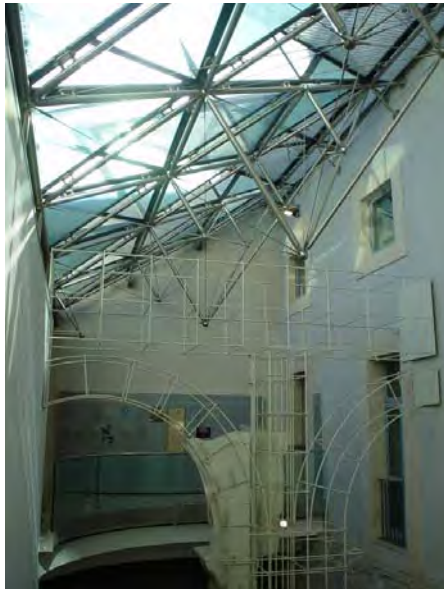
Imagen 38 que muestra una zona interior del museo cubierta por una estructura tridimensional.
