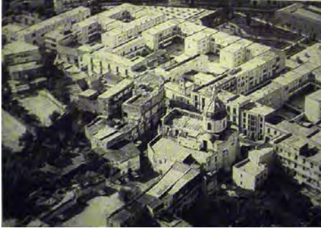
Imagen 39.- Vista del sitio antes de la intervención
