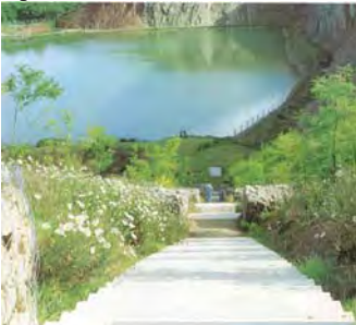
Imagen 111 Vista de las escaleras, las huellas y plataformas apoyadas sobre el terreno
