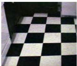
Imagen 122.- Pavimento de cocina en plástico reciclado
