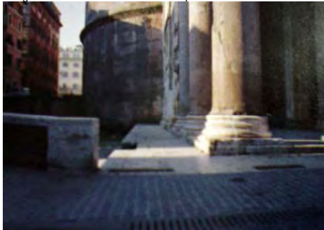
Imagen 76.- que muestra el canal de captación de agua pluvial
