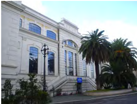
Imagen 5 que muestra la fachada recuperada de la central eléctrica
