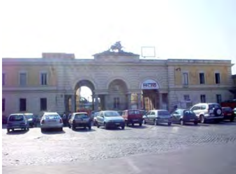
Imagen 7.- Entrada y fachada principal ya rehabilitada de los ex mataderos.
