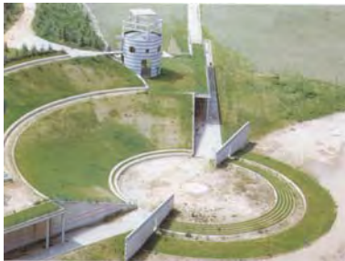
Imagen 107 Vista aérea del teatro al aire libre y las torres de servicios
