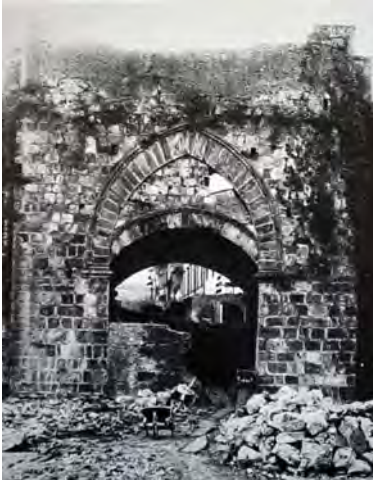
Imagen 47: Abertura de una puerta tapada
