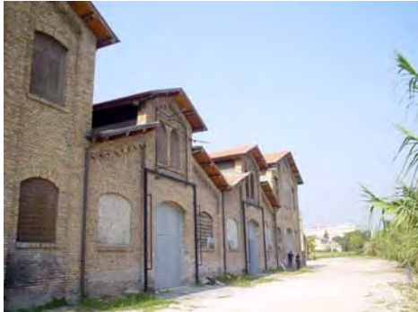
Imagen 10 Edificio recuperado en el cual se encuentran las salas de espectáculo, al fondo podemos ver el espacio destinado al teatro al aire libre.
