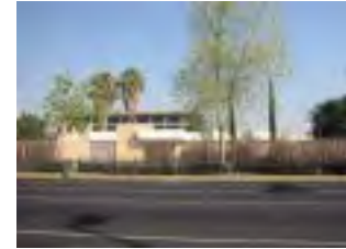
Edificio Cendi (p. demolición)
