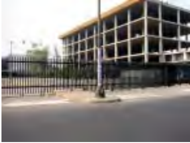
Edificio de SCT (pra demolición)
